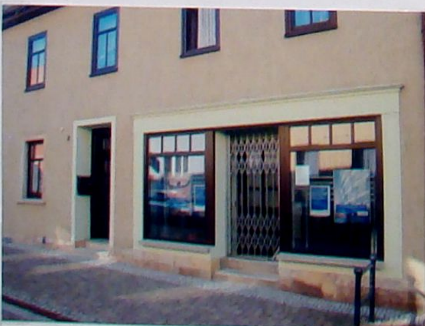
Das ehemalige Geschäftshaus Jobst im Juni 2010
