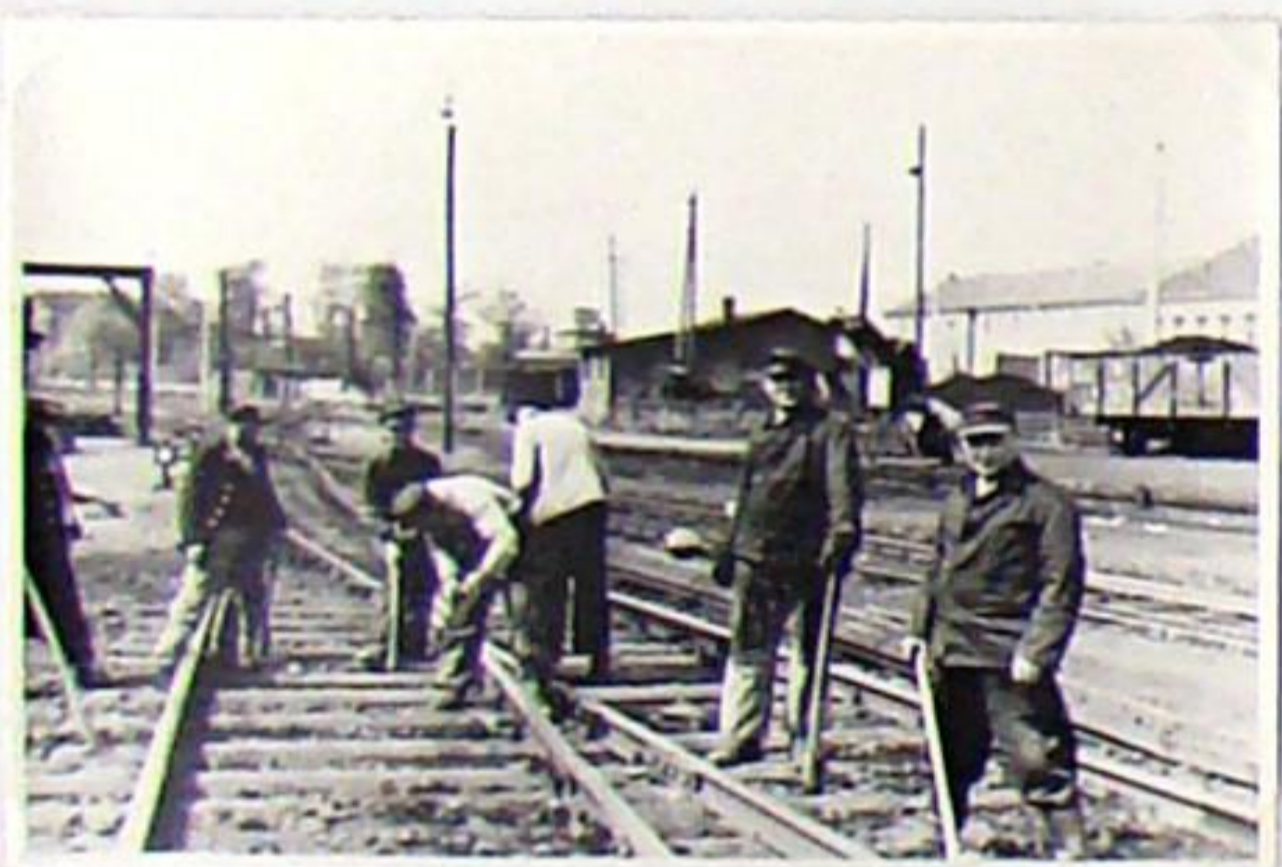
Die Gleisbaurotte der Berkaer Bahn beim Nachstopfen der Weiche 12 im Bahnhof Weimar-B. Der gerade Strang im Vordergrund führt zu den südlichen Gleisen 3 und 4 und in den ehemaligen Lokschuppen. Rechts ist Bahnsteig 2 angebunden. Im Hintergrund die Erfurter Straße.
