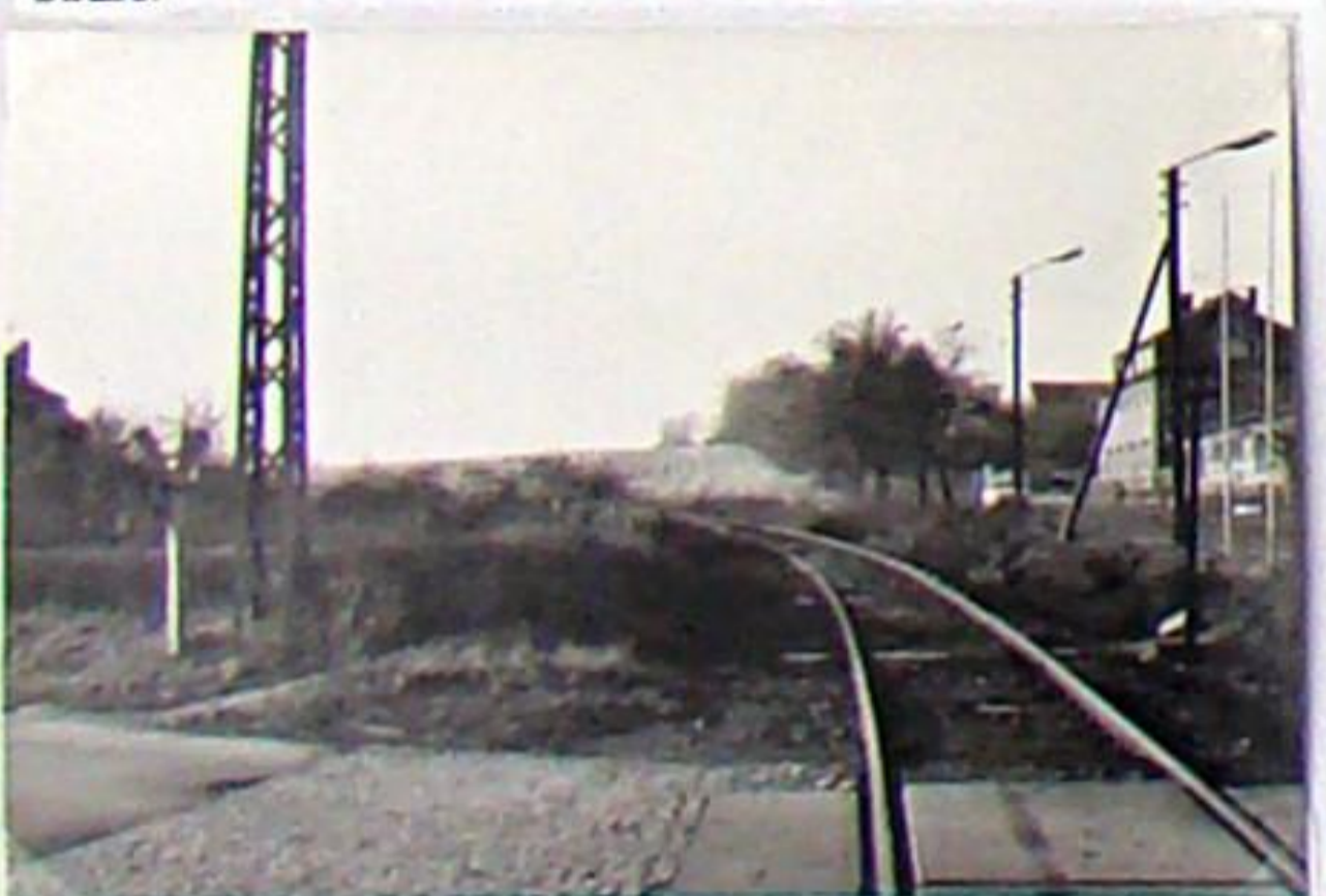
Bahnübergang Damaschkestraße – Westausfahrt des Berkaer Bahnhofs in Weimar über den „Galgenberg“ in Richtung Bad Berka im Jahr 1975. Schon dieser BÜ liegt in einer Steigung von 28‰.
