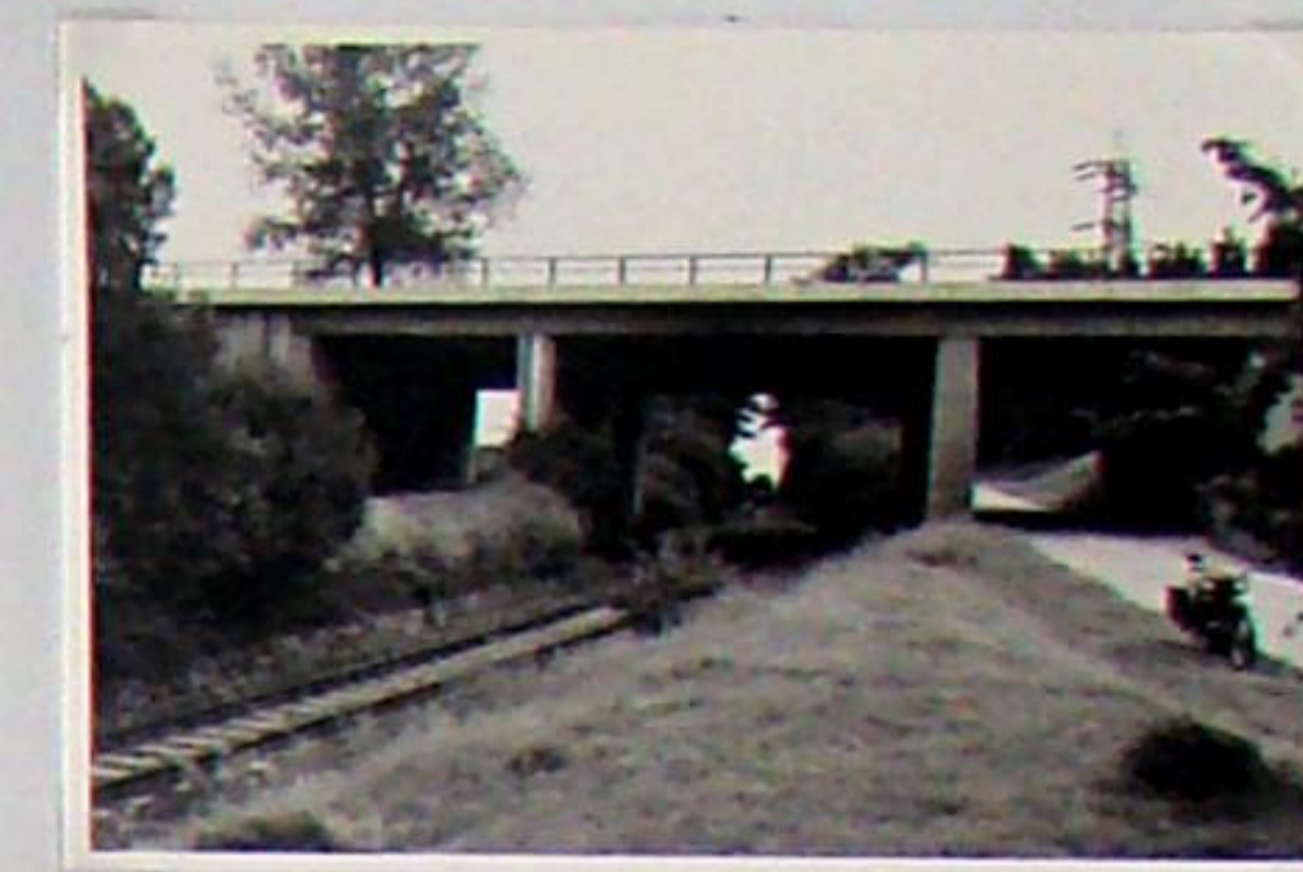
Autobahnbrücke der heutigen A4 oberhalb von Obergrunstedt 1984
