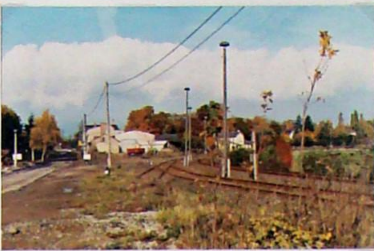
Bahnhof Nohra am 31.10.1995. Das zugeschüttete Gleis im Vordergrund bildete den Anschluss des Militärgleises
