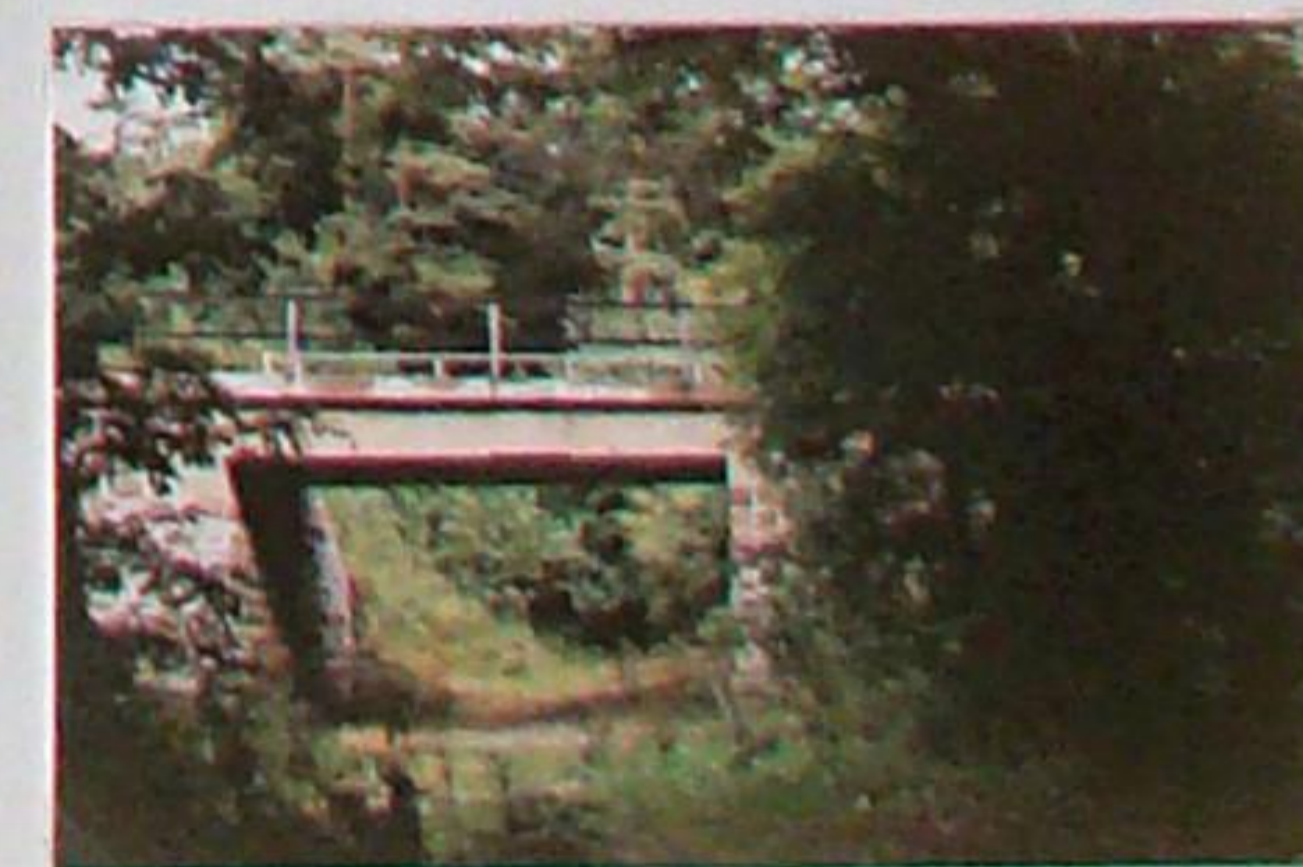
Diese Unterführung im Zuge der ehemaligen Ortsverbindungsstraße Schoppendorf – Legefeld wurde 1925 im oberen Bereich erneuert und verstärkt – Zustand am 25.08.1996
