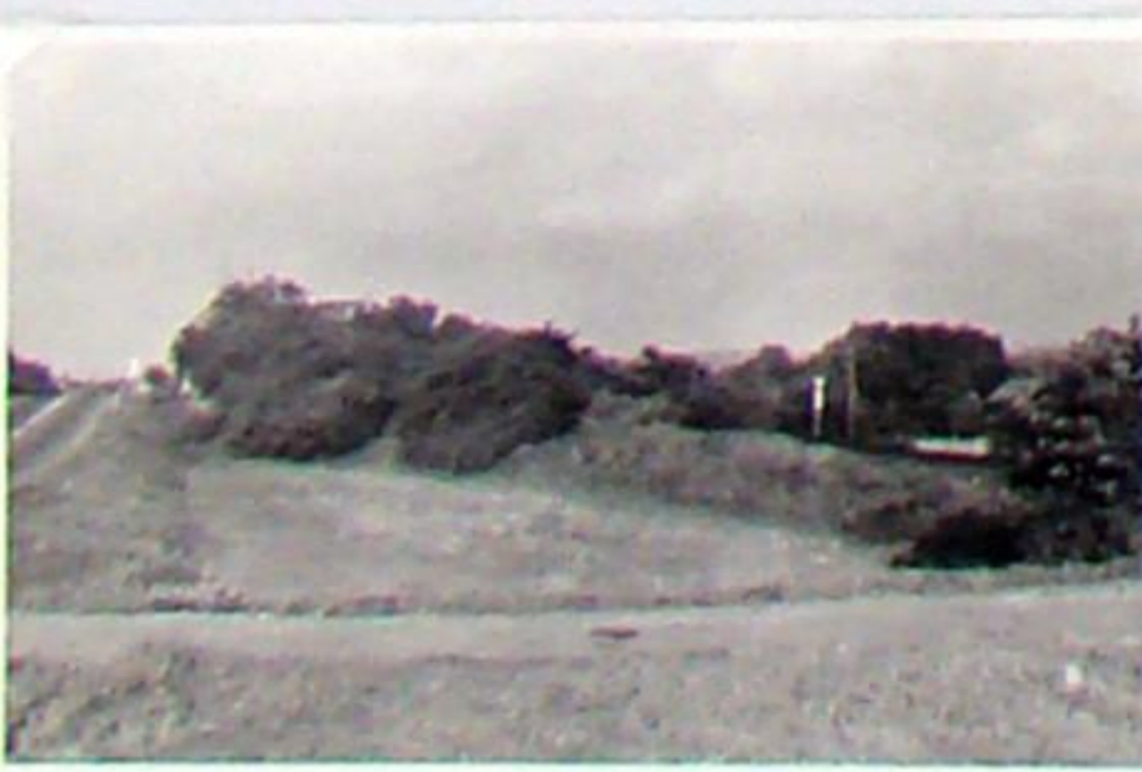
Zur Kostenersparnis legte die Baufirma die Gleise ursprünglich auf vorhandene Straßen – auch zwischen Weimar – Erfurter Tor und dem Gasthaus Neuwallendorf. Von da an begann der eigene Bahnkörper bis Bad Berka, dessen Zustand 1984 hier zu sehen ist.
