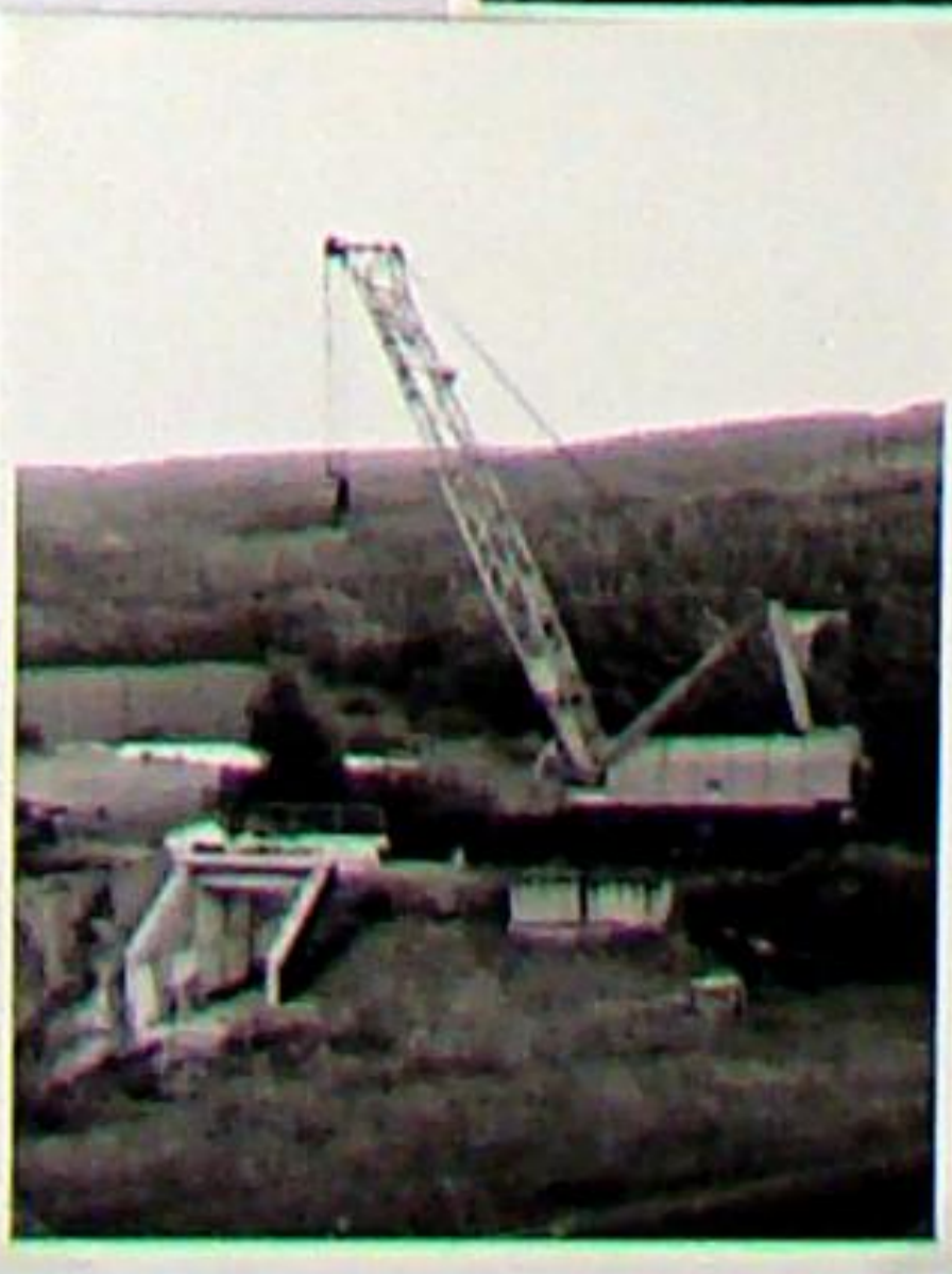
Der Einschub der kompletten Unterführung ist erfolgt. Der kleinere Kran dient zum Bereäumen der Baustelle. Schotterbett und Gleis auf der Unterführung fehlen noch. Die ausgebaute Brücke und das Gleisjoch liegen am Bahndamm.
