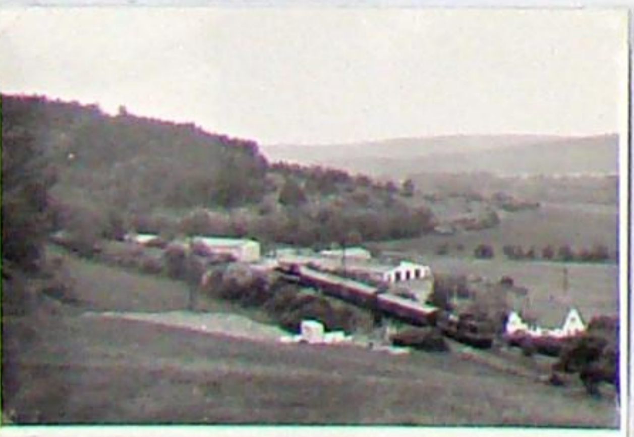
Wegen der Entgleisung einer Drehgestellachse am EDK im Gleisbogen zwischen km 4,5 und Hetschburg, konnten die Entladearbeiten am 27.05.1988 nicht beginnen. Als erster Zug an diesem Tag fuhr, nach der Bergung des Kranes, der Hilfszug des BW Erfurt ca. 20.00 Uhr nach Weimar.
