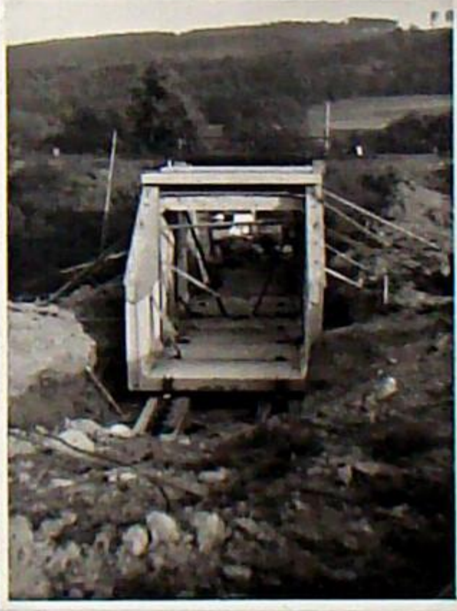
Die Güterwagen mussten einzeln von Bad Berka herangebracht werden.
