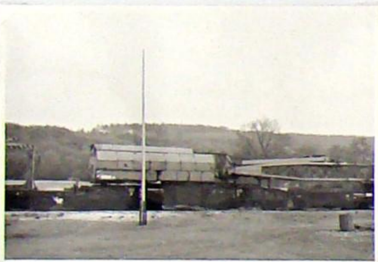
Am 25.05.1988 stand der große Eisenbahndrehkran EDK 1000/2 aus Leipzig-Eutritsch in Bad Berka für die Bauarbeiten an der Hetschburger Brücke bereit.
