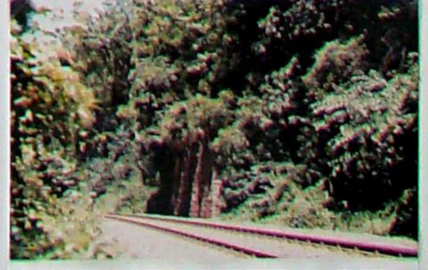
Am 24.07.1994 ist der Standort der Schutzbrücke nur noch an der verbliebenen Rückwand zu erkennen.
