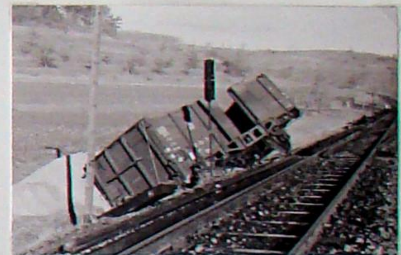
Entgleisung eines Om-Güterwagens genieteter Bauart „Königsberg“ mit Düngerladung am 29.11.1959 neben der Weiche des Ladegleises der Haltestelle Hetschburg. Das Hauptgleis besteht noch aus Stahlschwellen mit Haken-Unterlagsplatten.
