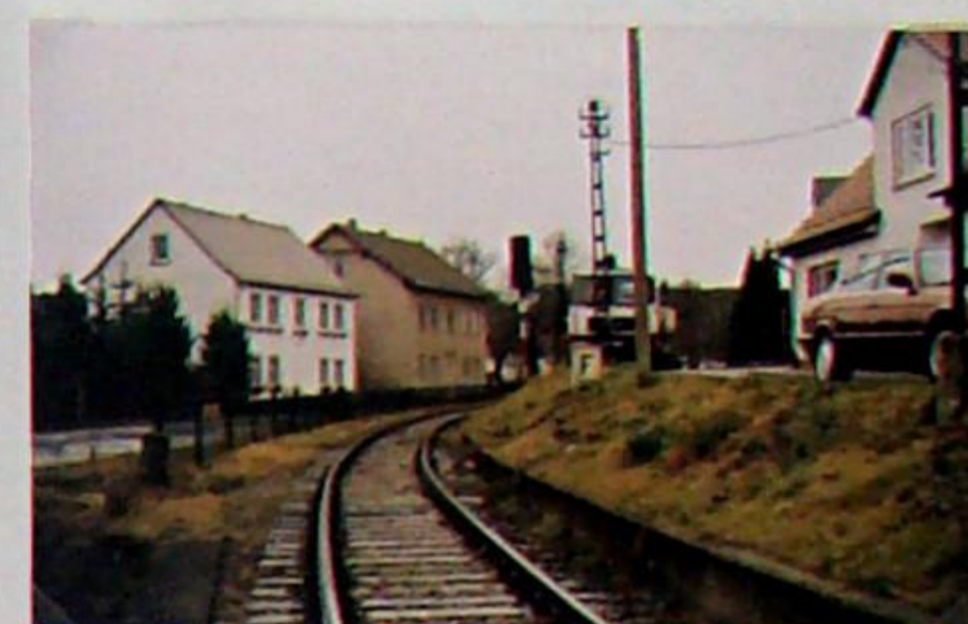
ausgeschaltetes Einfahrsignal A kurz vor Abbau am 13.12.1999
