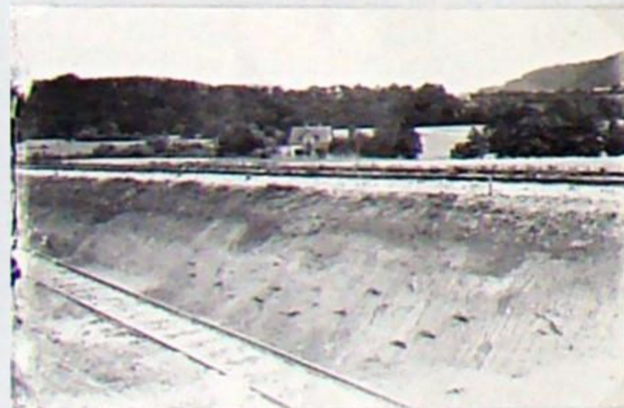
Zur Verringerung der Steigungen auf der Strecke wurde zwischen Hetschburg und Bad Berka 1926 das Streckengleis tiefer gelegt. Im Hintergrund die Schmalzgrube Bad Berka.
