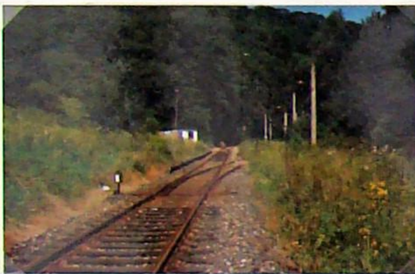
Obere Anschlussbahnweiche des Dämmstoffwerkes, bis 1994 in Betrieb
