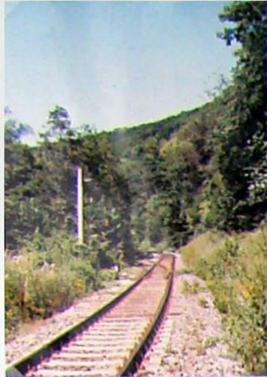
Die untere Anschlussweiche des Dämmstoffwerkes nach der Stilllegung am 24.7.1994
