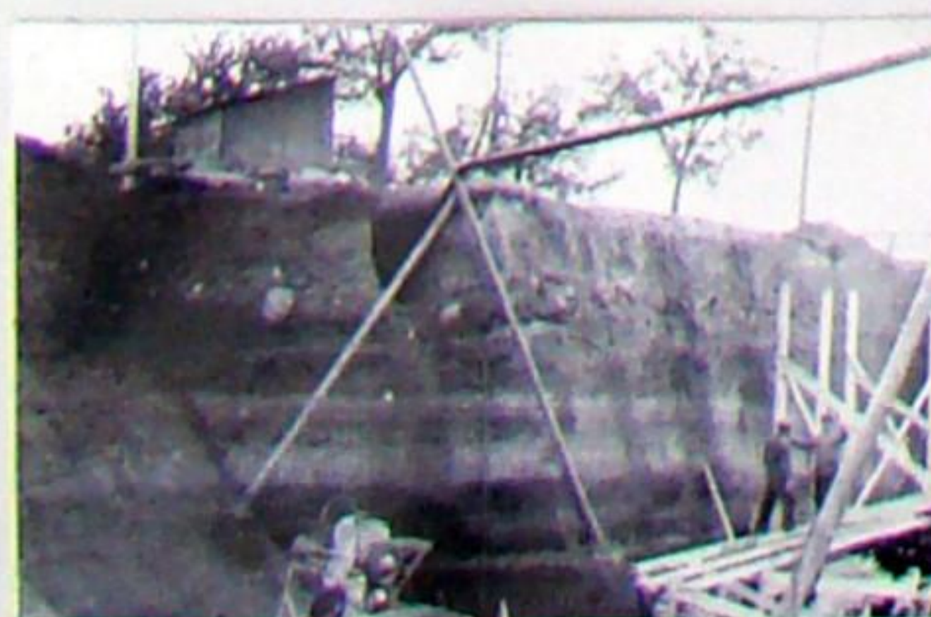
Vorbereitungsarbeiten zum Herstellen der Stampfbeton-Straßenbrücke 1926, die später 1991 teilernuert und verbreitert werden musste.
