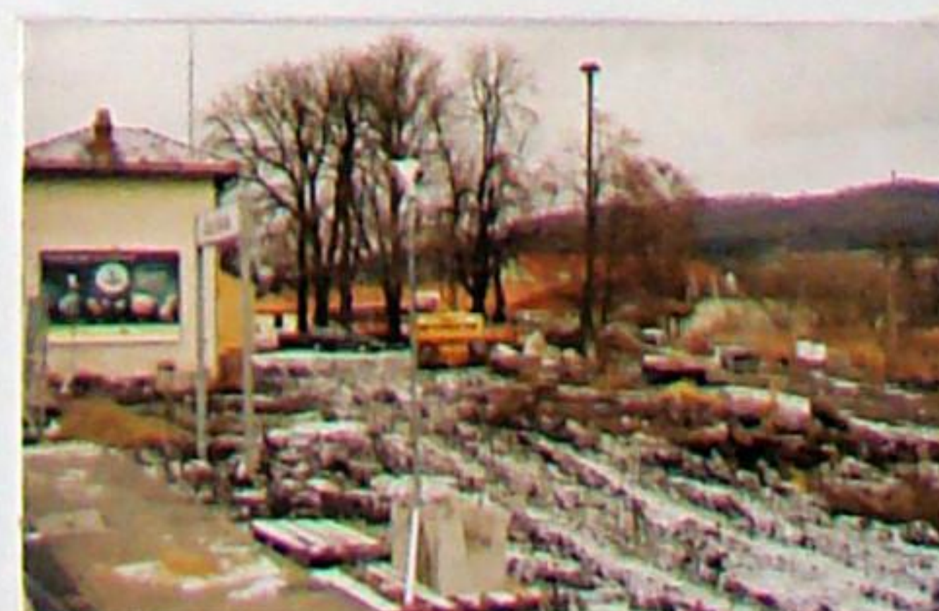
Bahnhof Bad Berka am 19.12.1999 Bahnsteig 2 ist noch im Bau. Die einstige Wiese mit Blumenbeeten und Ziersträuchern rechts vom Wasserturm ist leider „umgepflügt“
