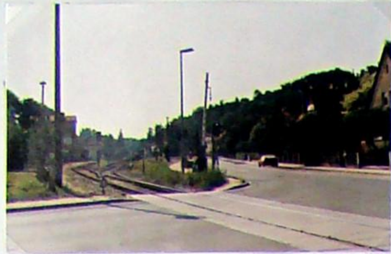
Blick auf die Bahnhofs-einfahrt mit der alten Weiche 1 am 19.8.1995
