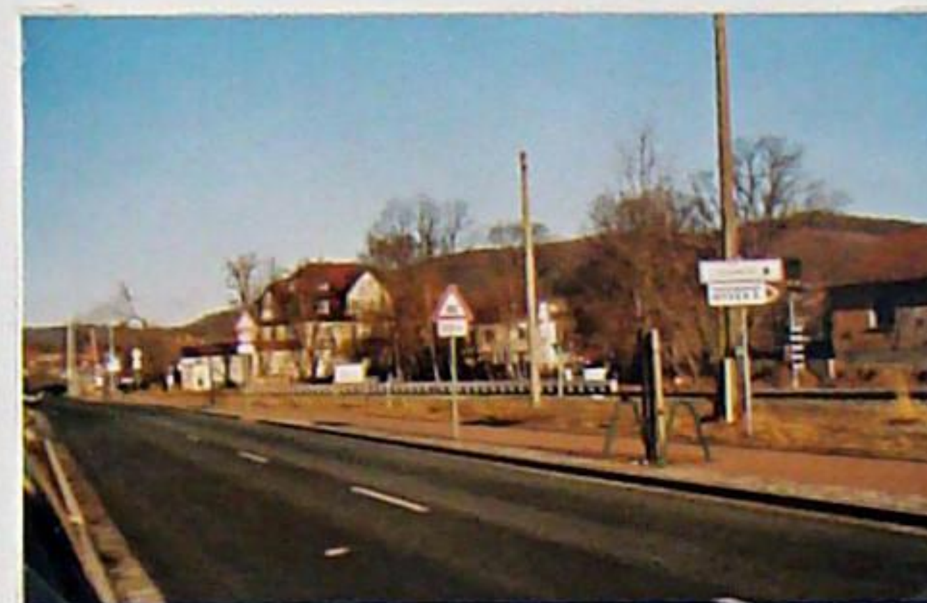
...ist am 19. Januar 1999 der neue Bahnsteig 1 noch im Bau.
