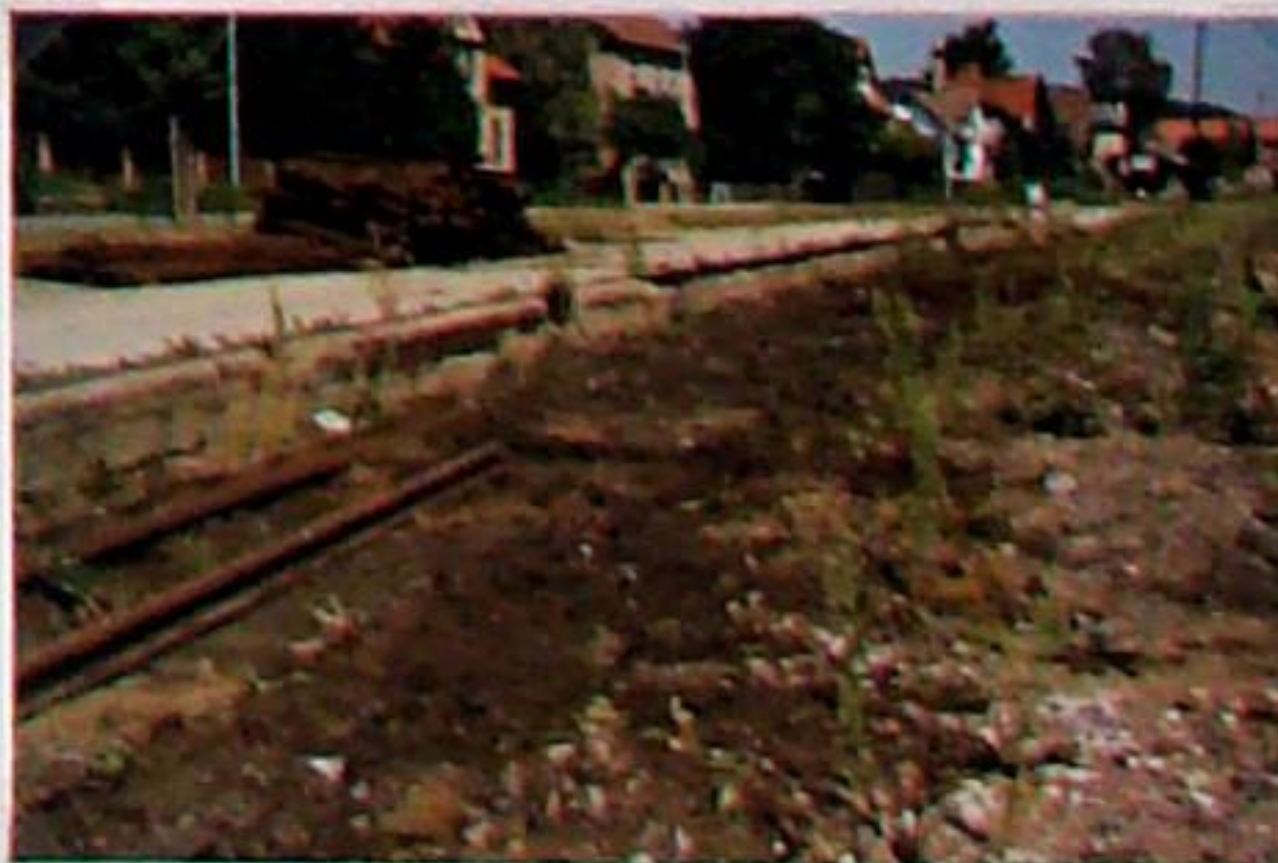
Gleisabbau an der Ladestraße am 12.8.1997
