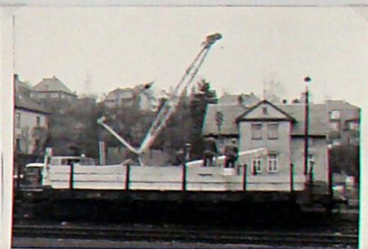
Entladearbeiten an der Ladestraße in Bad Berka Anfang 1968
