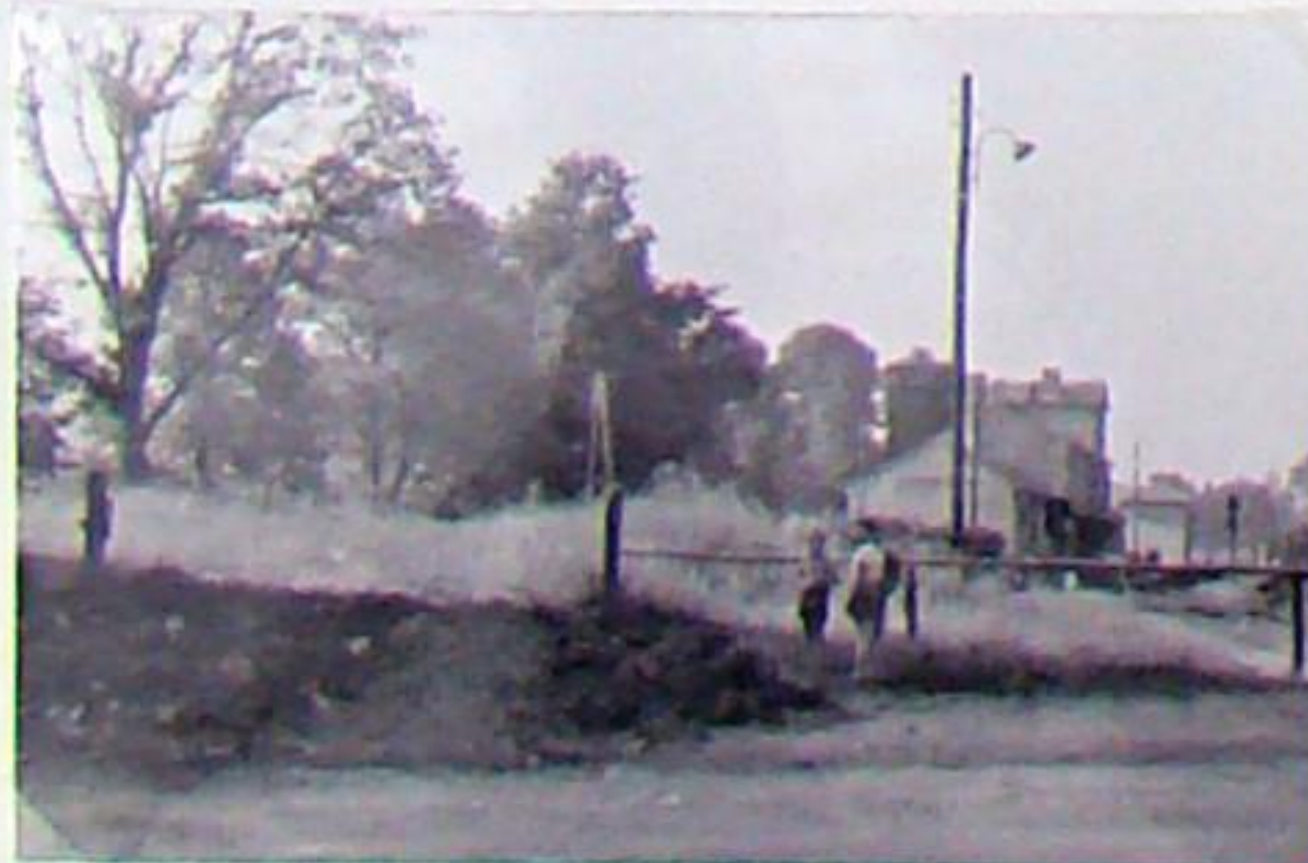
Der „Bahnhofsberg“, die Zufahrt für die ehemalige Kopf- und Seitenrampe, wird am 02.08.1962 zum Zweck der Straßenverbreiterung abgetragen.
