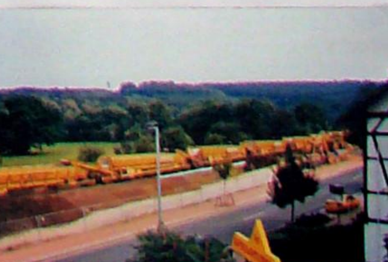
Zwischen dem 05.07. und 09.08.2002 baute die Firma Wiebe das Streckengleis nebst Unterbau zwischen dem Anschluss Sprengstofflager und Imbrücke in Bad Berka völlig neu. Die Allmaterialien wurden auf der ehemaligen Ladestraße entladen und von dort mit LKW's abtransportiert.
