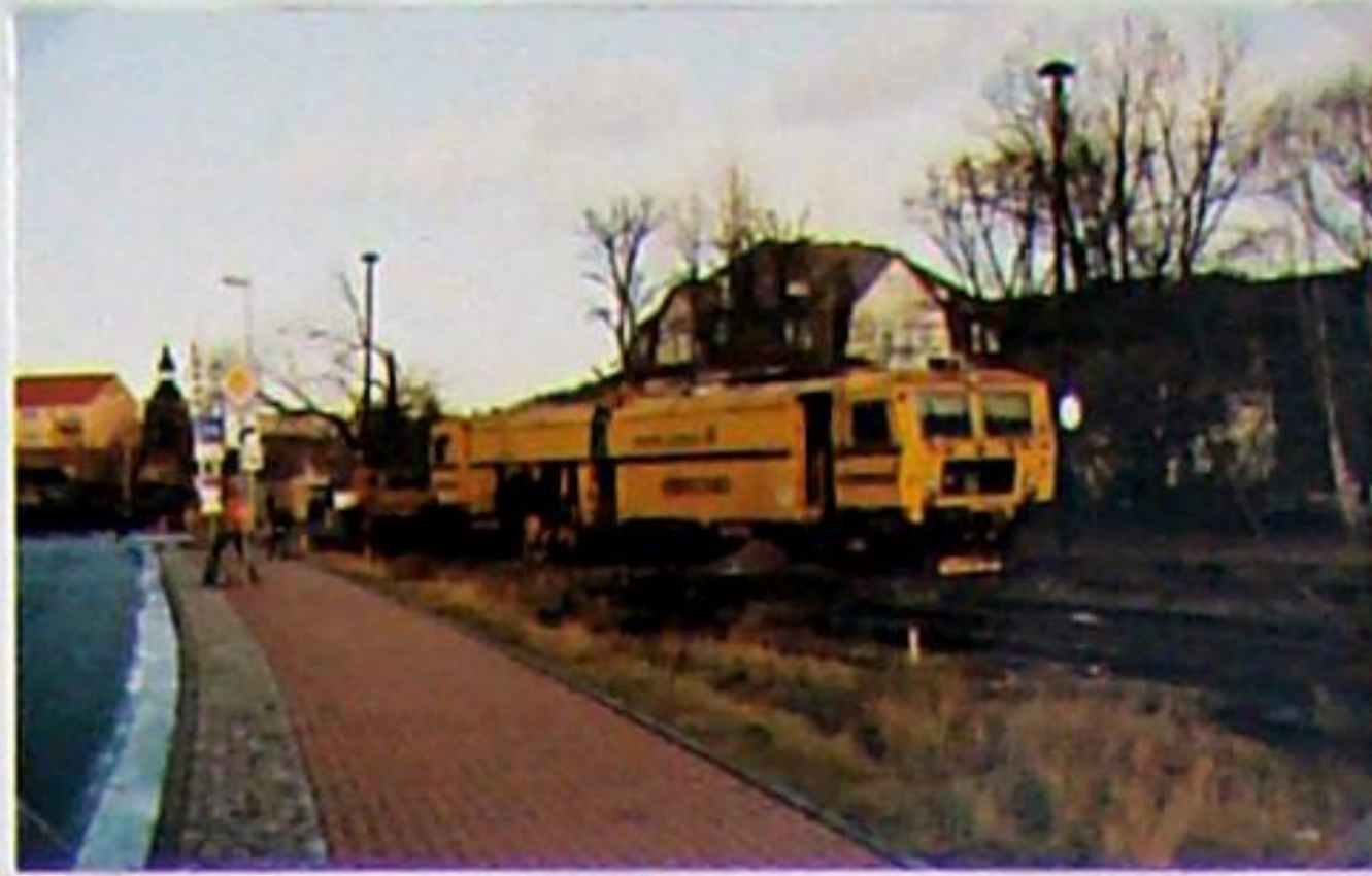
Nach dem Einbau der neuen Weiche 1 arbeitet die Stopfmaschine am Nachmittag des 14.12.1999 zwischen Bahnübergang und Gleis 1.
