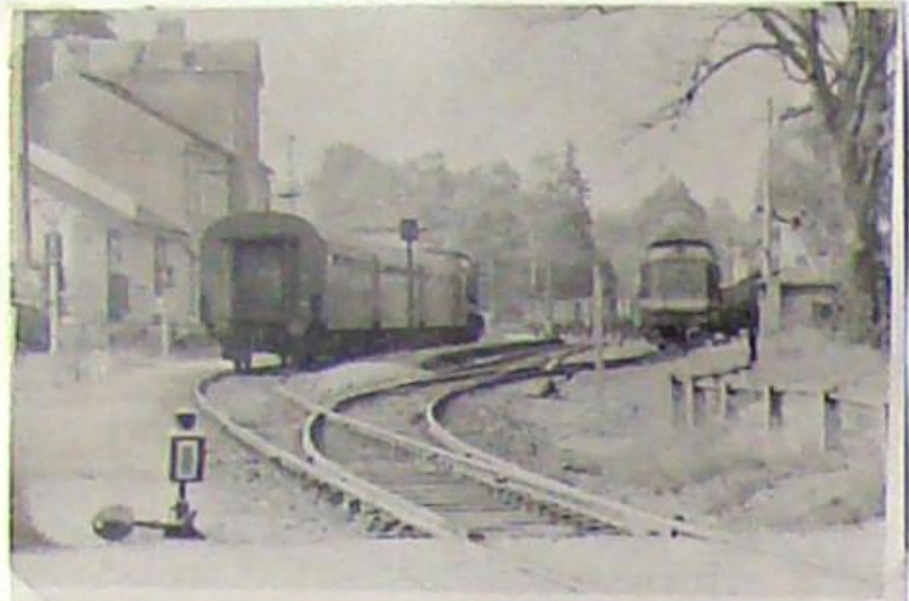
Einfahrt eines Personenzug mit vierachsigen Rekowagen am Bad Berkaer Bahnsteig 1 in den 1980er Jahren.- In Gleis 3 (rechts) wartet der Gegenzug auf Ausfahrt.
