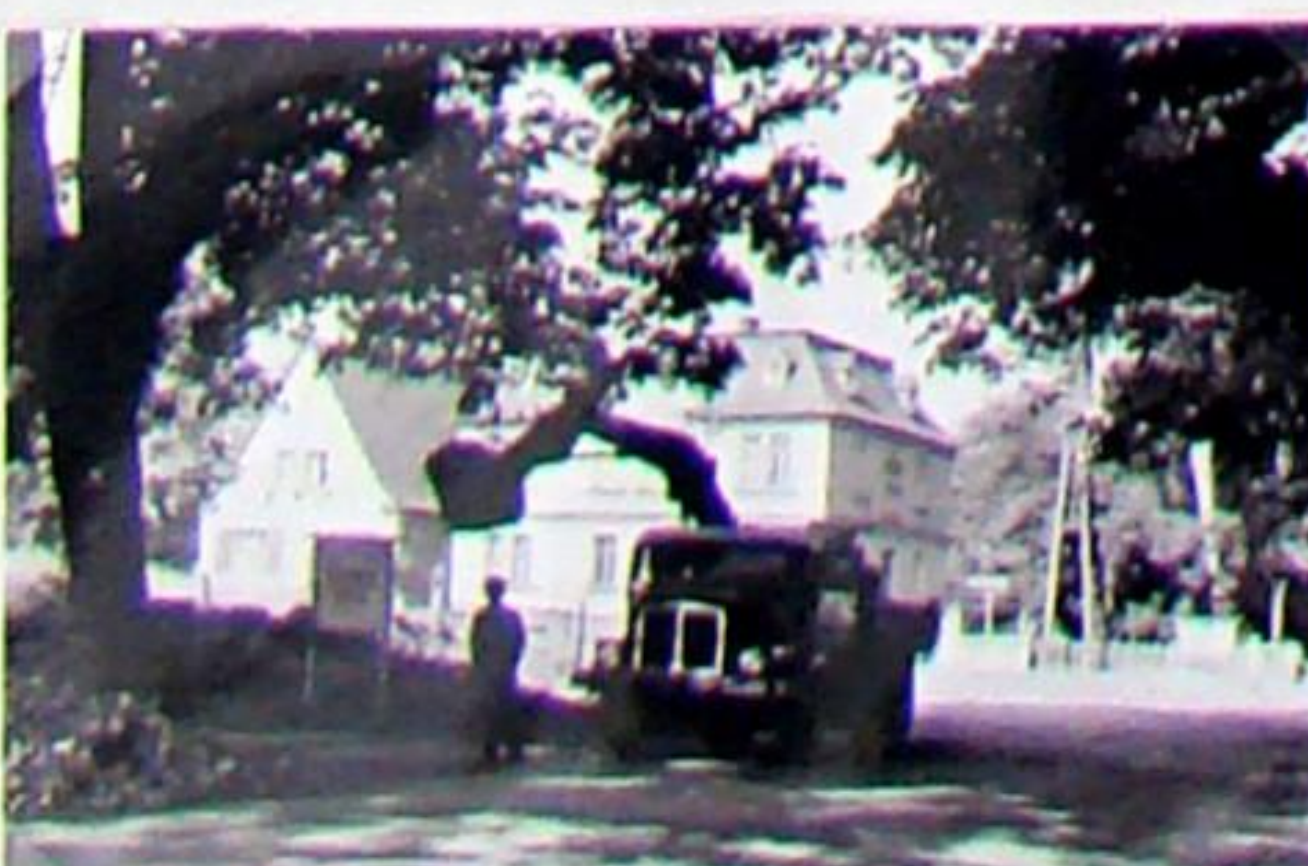
Bagger und LKW S4000 sind gegenüber dem Kurhotel im Einsatz.
