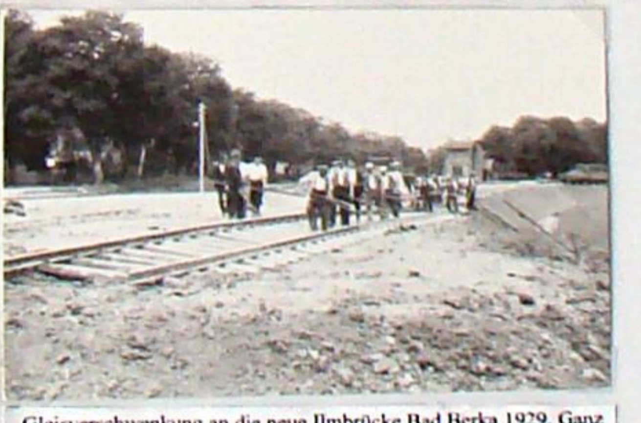
Gleisverschwenkung an die neue Ilmbrücke Bad Berka 1929. Ganz links mündete das Blankenhainer Gleis in das Hauptgleis, welches damals in seiner Verlängerung auf der Landstraße nach Tannroda führte.
