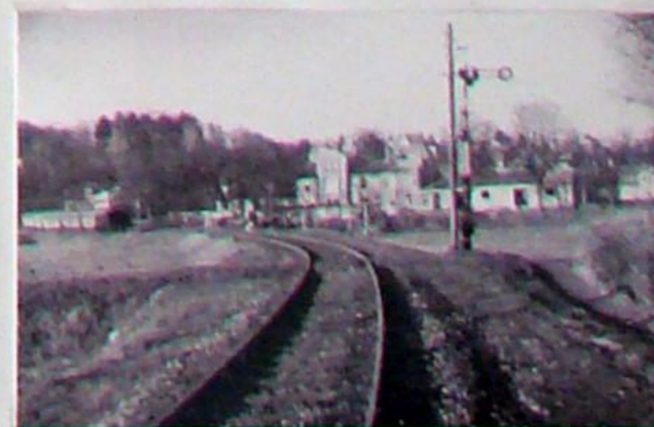
Blick vom Blankenhainer Streckengleis auf das Einfahrsignal C des Bahnhofes Bad Berka. Gebäude und Wasserturm sind noch im Bau, links steht der T05 am Bahnsteig. Die elektrische Signalbeleuchtung ist im Frühjahr 1946 noch nicht verändert.
