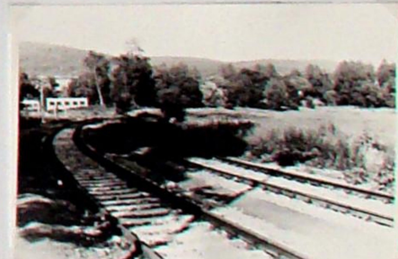
Gleis 7 und Gleis 8 des Bahnhofes Bad Berka nach dem Umbau auf Betonschwellen 1982
