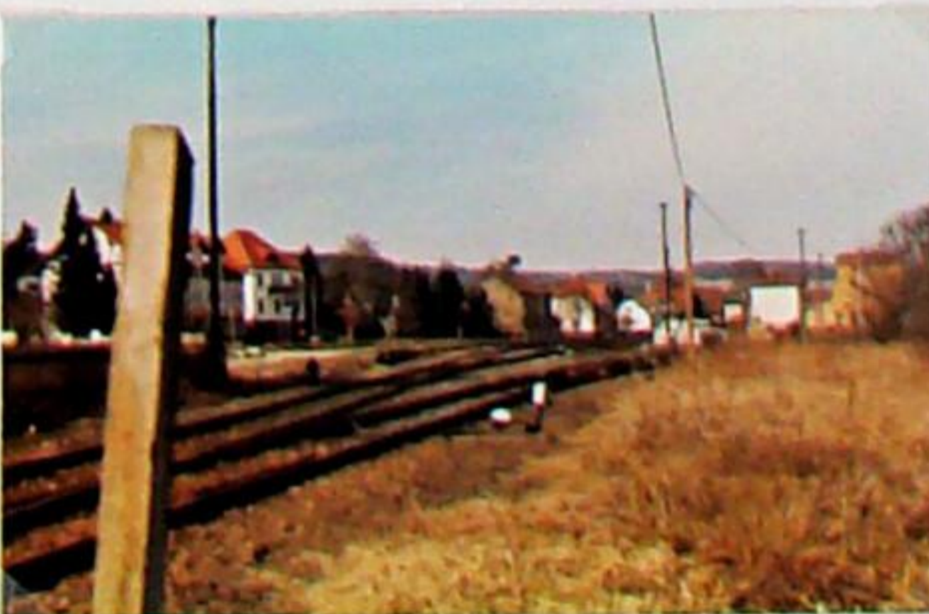
Die Einfahrweiche 11 aus Richtung Tannroda ermöglichte in abzwiegender Stellung die Fahrt nach GI 7 (ehem. Blankenhain) und die W 10 im Vordergrund in das GI 8. Beide waren durch die Gleissperre II verschlossen. Bad Berka 07.04.1996
