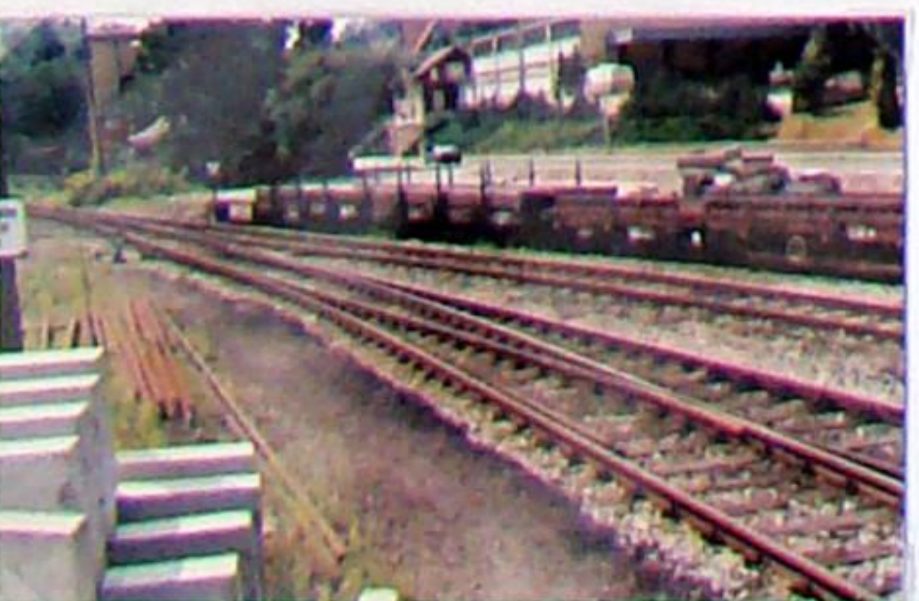
19.8.1995: Blick auf Weiche 8 und die Tieframpe. Die L-F-Tafel (10 km/h) galt nur für die Güterzüge bei Fahrt über die Ilmbrücke.
