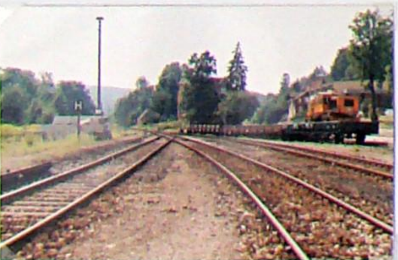
19.8.1995: Blick auf die Ausfahrt Richtung Tannroda, links noch ein Reststück der alten Langschwellen-Bahnsteigkante des Hausbahnsteiges
