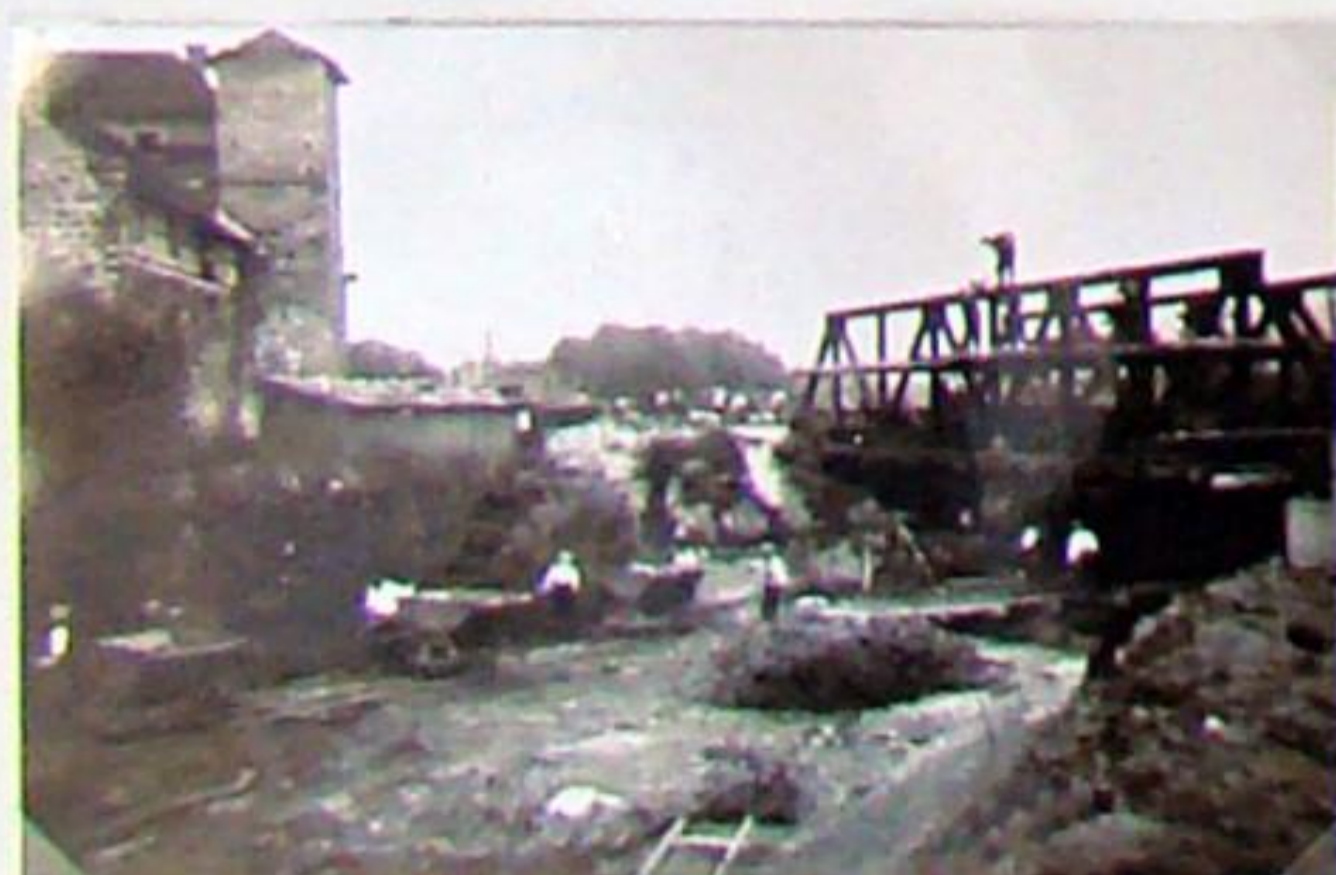
Während oben noch Gleisarbeiten zum Brückenanschluss erfolgen, wird unten noch das Flussbett beräumt und „begradigt“. Die Scheunen hinter der alten Brauerei sind abgerissen.
