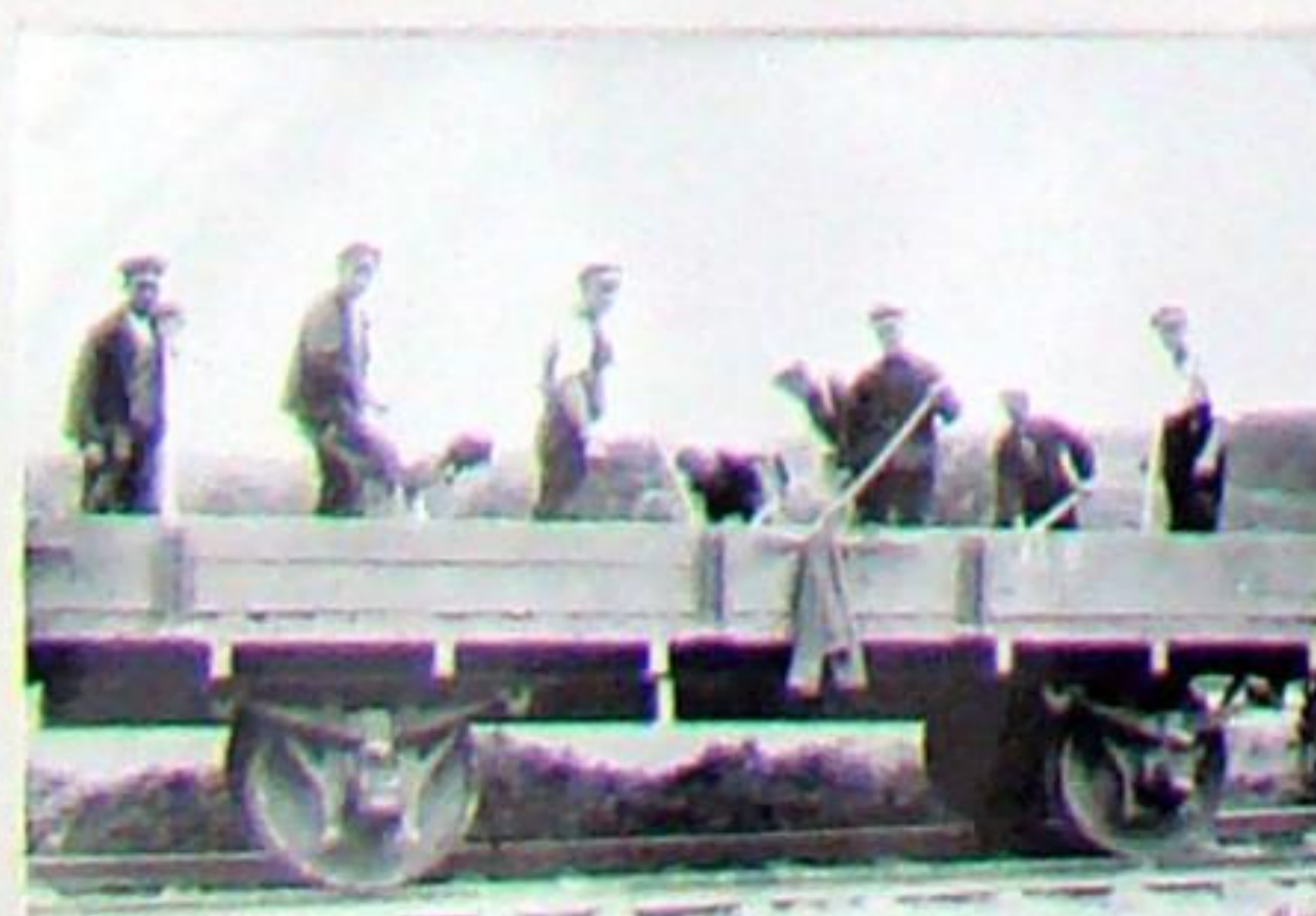
Nachdem das Gleis hinter der Brücke befahrbar ist, wird die Dammschüttung vorangetrieben. Im Hintergrund das Hartmannhaus.
