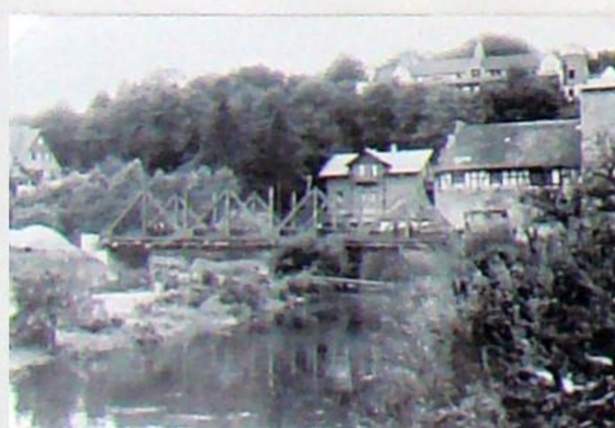
Blick auf die Brückenbaustelle aus dem Ilm-Flussbett von Südosten
