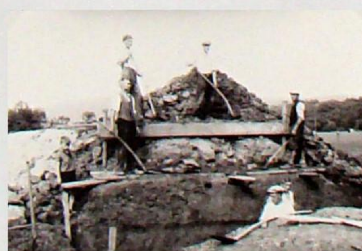
Auch die Baugruben für die Widerlager der Flutbrücken werden von Hand ausgeschachtet.
