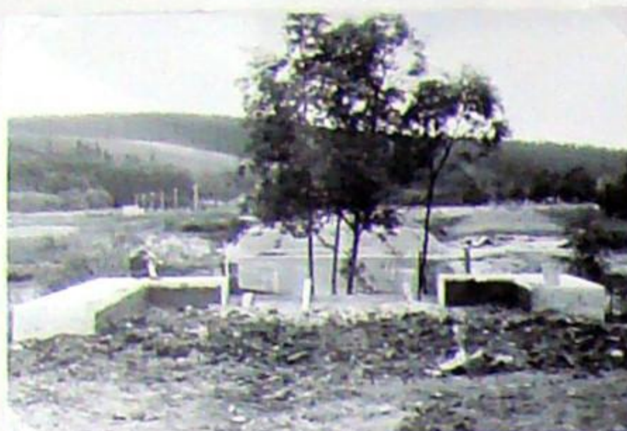
Nachdem nur noch die Strecke Bad Berka – München auf der Landstraße verlief, erfolgte deren Verlegung im Laufe der Jahre 1930/31 auf eigenen Bahnkörper. Hier die neuen Fundamente der „Hansen“-Brücke.
