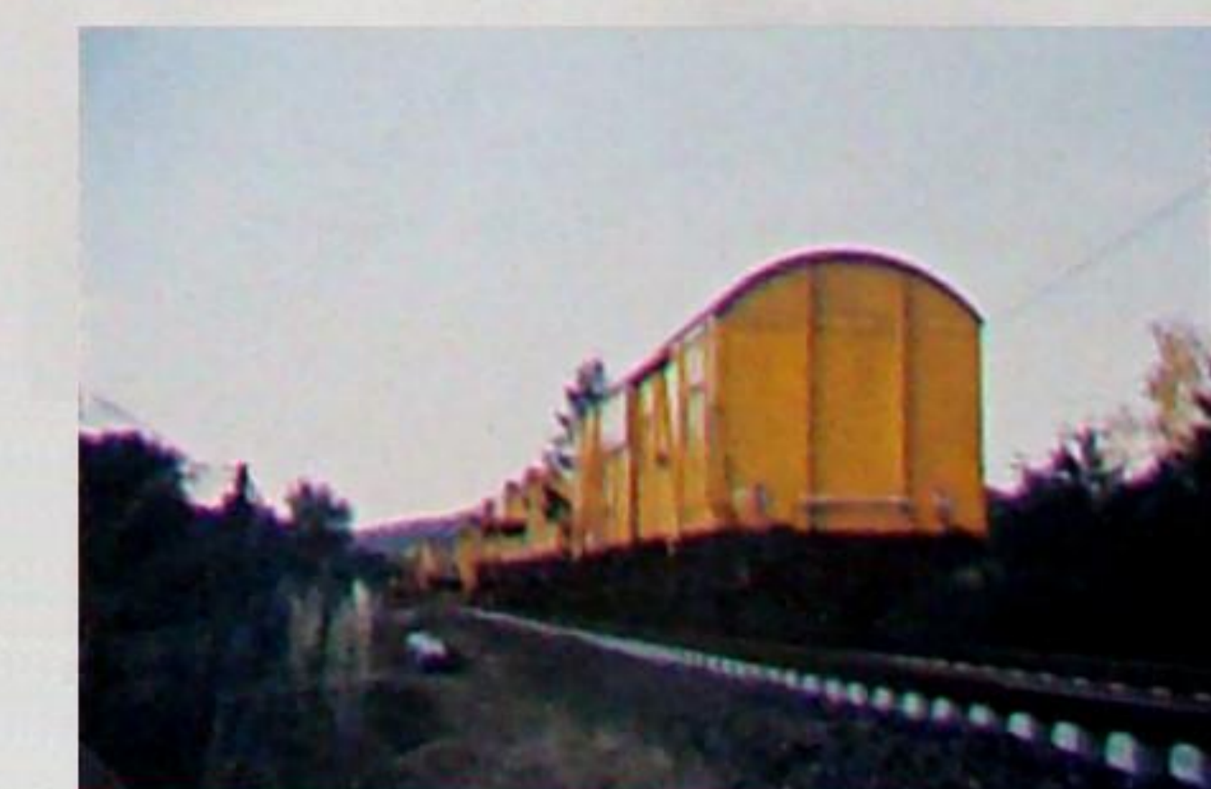
Hinter dem Umbauzug blieben die alten Schienen auf den Schwellenköpfen zurück. Die Schotterbett-Reinigung und Auffüllung sowie die Einbringung des Frostschützes erfolgten später vom neuen Gleis aus.
