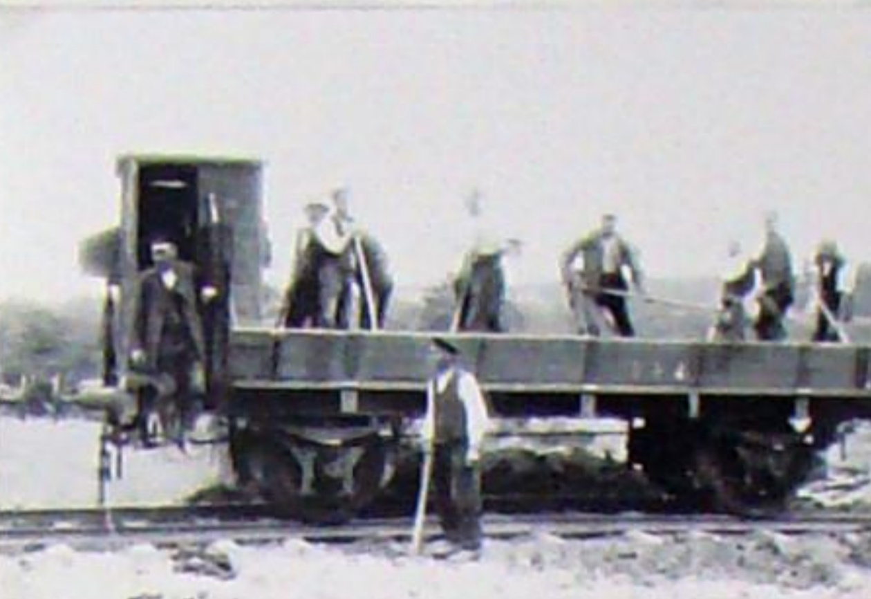
Nur dieser Arbeitswagen, Nr. 4, besitzt eine Handbremse!
