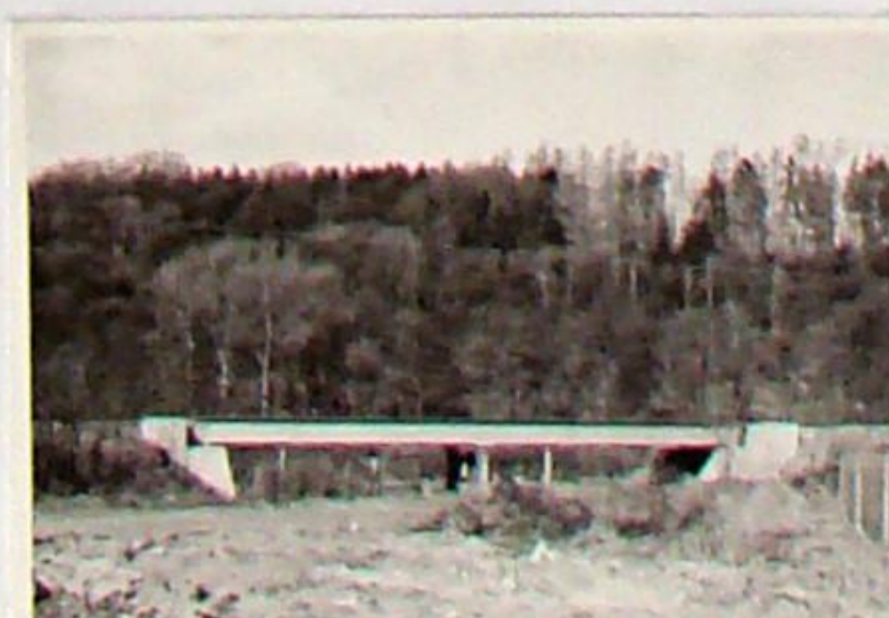
Die untere Flutbrücke oberhalb vom Sportplatz Bad Berka nach der Sanierung am 19.3.1992
