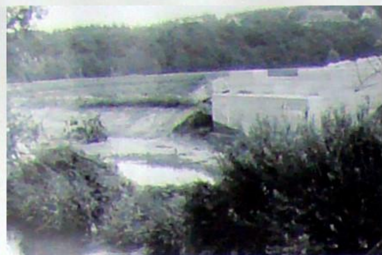
Nachdem nur noch die Strecke Bad Berka – München auf der Landstraße verlief, erfolgte deren Verlegung im Laufe der Jahre 1930/31 auf eigenen Bahnkörper. Hier die neuen Fundamente der „Hansen“-Brücke.
