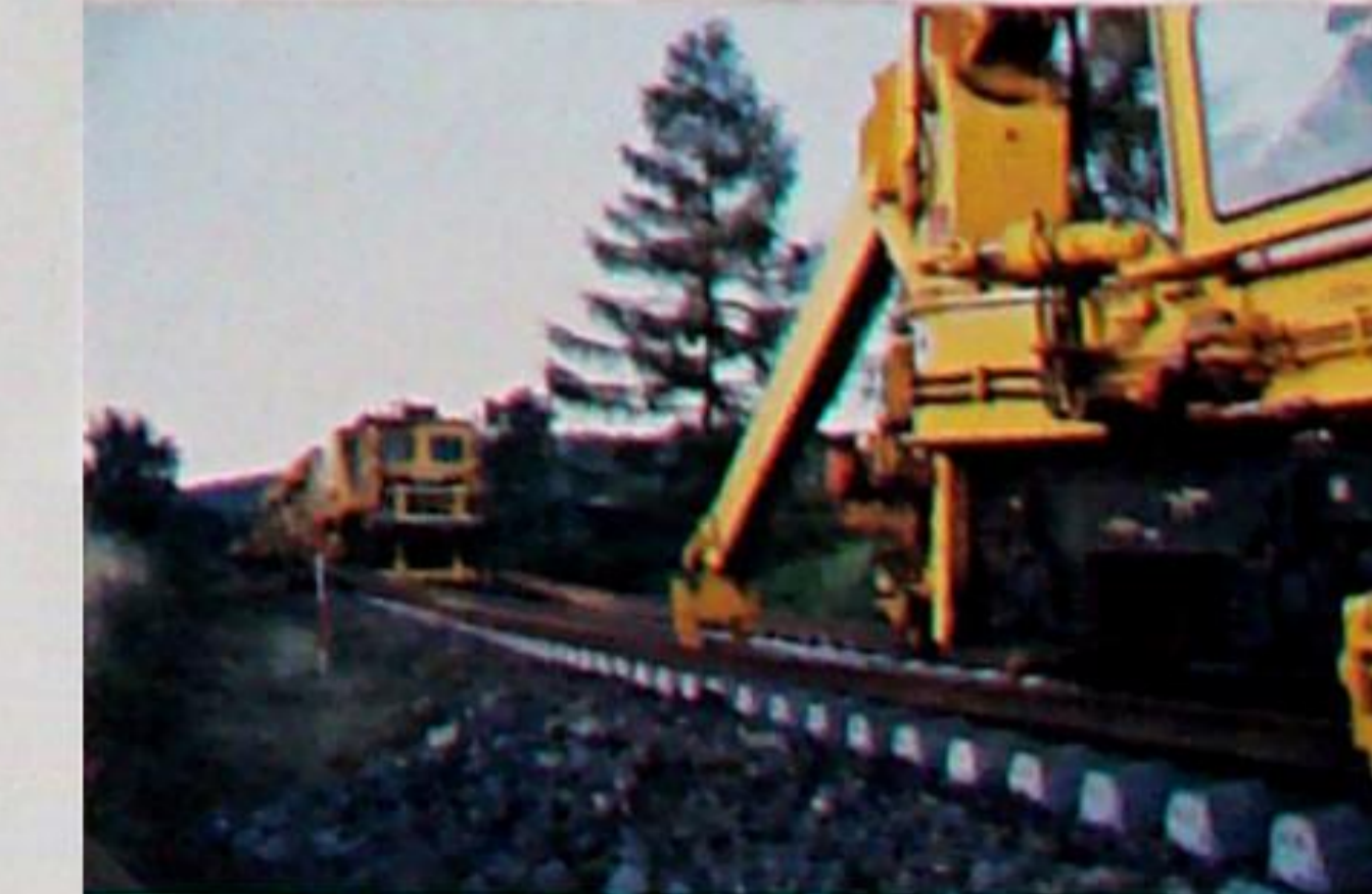
Nochmals die Greifarme der Schienen – Verlegemaschine, diesmal von hinten.
