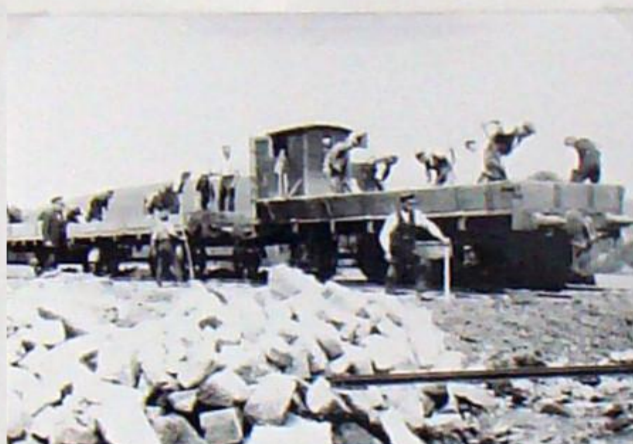
Unten liegen die nächsten Schienen zur Gleisverlängerung bereit.
