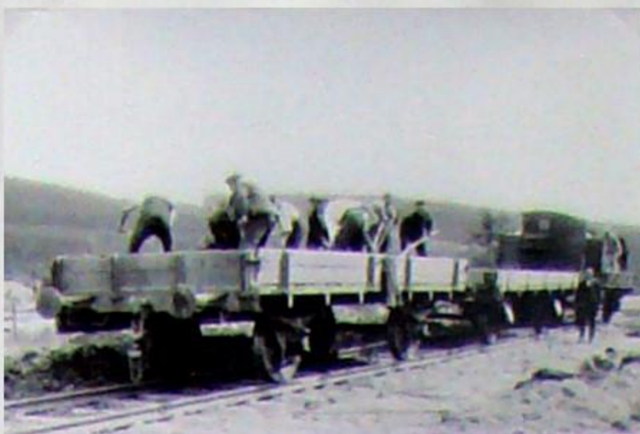
Die Arbeiten werden in reinem Handbetrieb durchgeführt. Die Erdstoffe stammen aus dem Bereich Zementwerk und von der Strecke zwischen Legefild und Hetschburg
