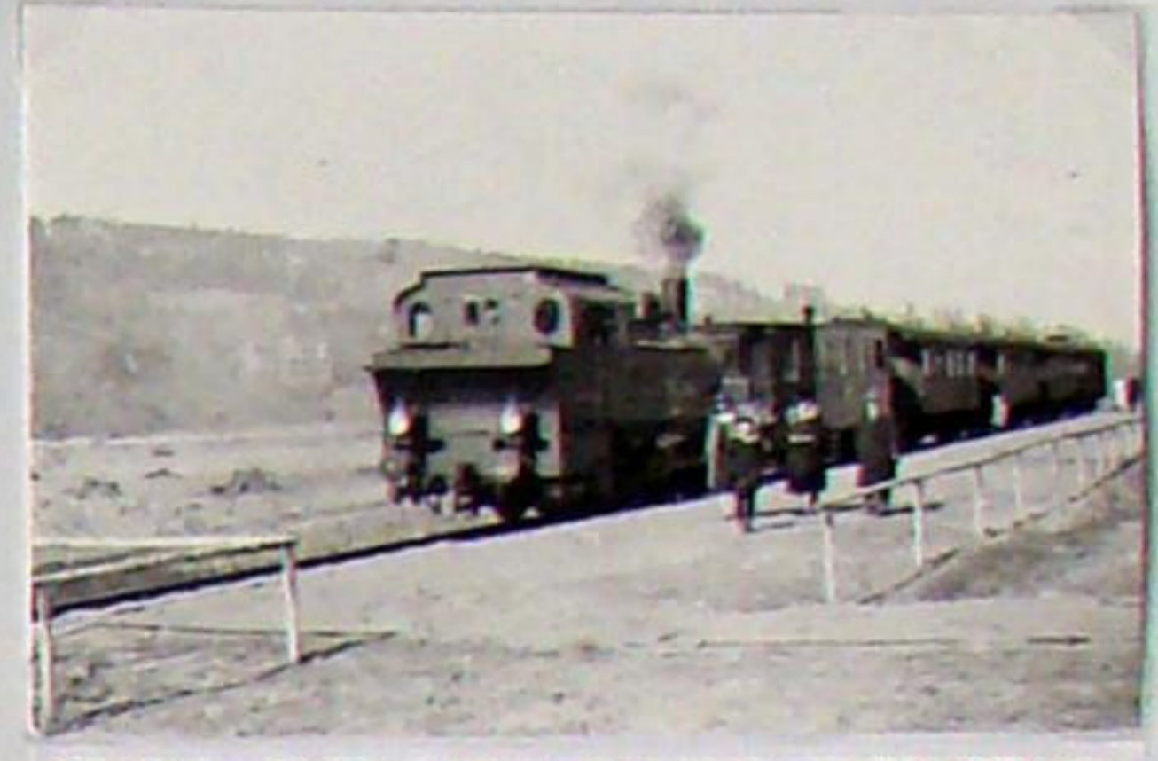
Der Haltepunkt Dammbachsgrund entstand vermutlich 1931 im Zusammenhang mit dem geplanten Reichs-Ehrenhain. Er diente nur zum Aussteigen aus Zügen mit Fahrtziel Kranichfeld und war bis 1943/44 in Betrieb.
