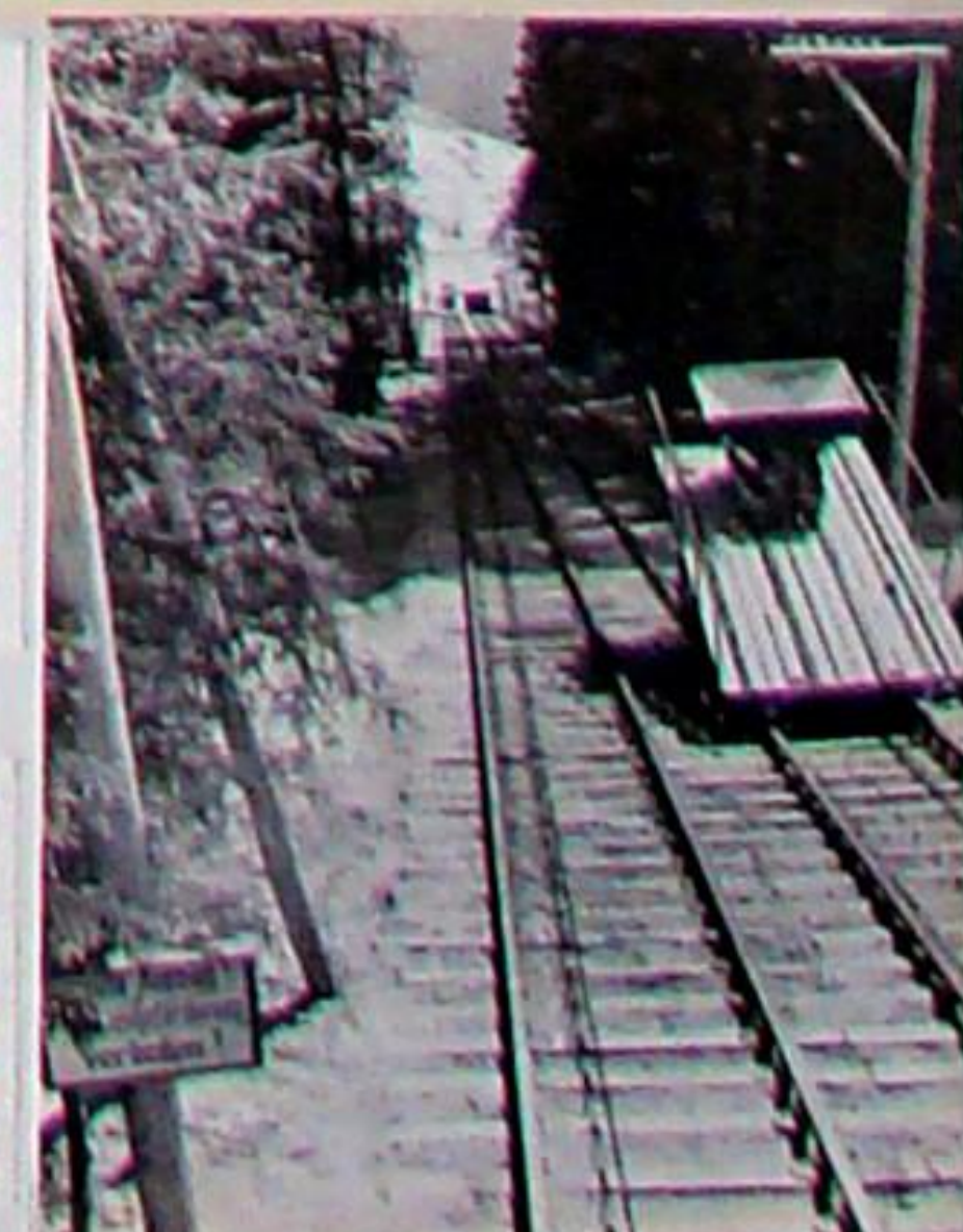
Der Neubau der Tbe-Heilstätte auf der Harth erforderte große Mengen an Baustoffen. Deshalb wurde 1951 neben der „Schwarzen Brücke“ über die Ilm, am heute zugewachsenen Weg zum Dreiteichsgrund, ein Materialbahnhof mit anschließender Standsseilbahn errichtet. Die Anschlussweiche lag im km 18,770 vor dem Anschluss Martinswerk. Das Gleis beschrieb einen Bogen von 90 Grad und teilte sich dann zweimal auf. Beide Güterbühnen fassten bis zu drei Kipploren die an den Lagerplätzen von Hand gefüllt, über Fluss und Straße, nach oben gezogen wurden. Rechts ist die Seilbahn von oben zu sehen. Zustand 1952
