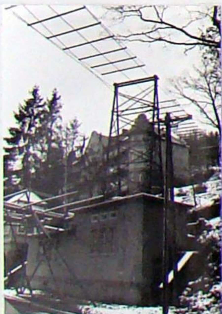
Zum Montieren von Trag- und Zugsseil für die Seilbahn musste zum Schutz von Straße und bebauter Grundstücke eine Hilfsabspannung errichtet werden. Eine Schutzbrücke für die Tannrodaer Straße gegen herab fallende Kohle wurde aber nicht gebaut.
