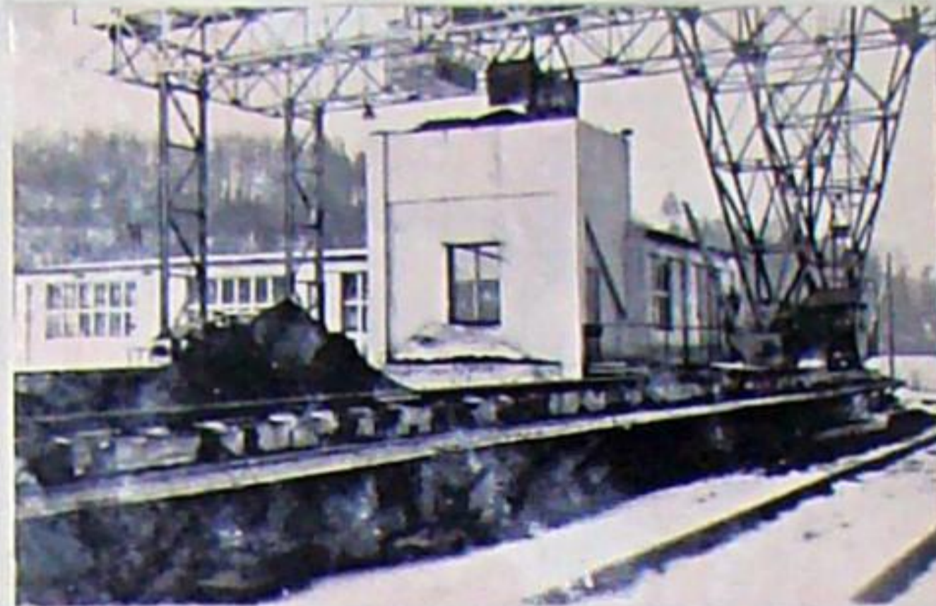
Der Portalkran konnte die Kohle aus dem Waggon oder aus dem Bunker entnehmen. Die rund 500 m lange Drahtseilbahn begann im dahinter befindlichen Maschinenhaus. Die Anlage war aus technischen Gründen nur bis 1960 in Betrieb.
