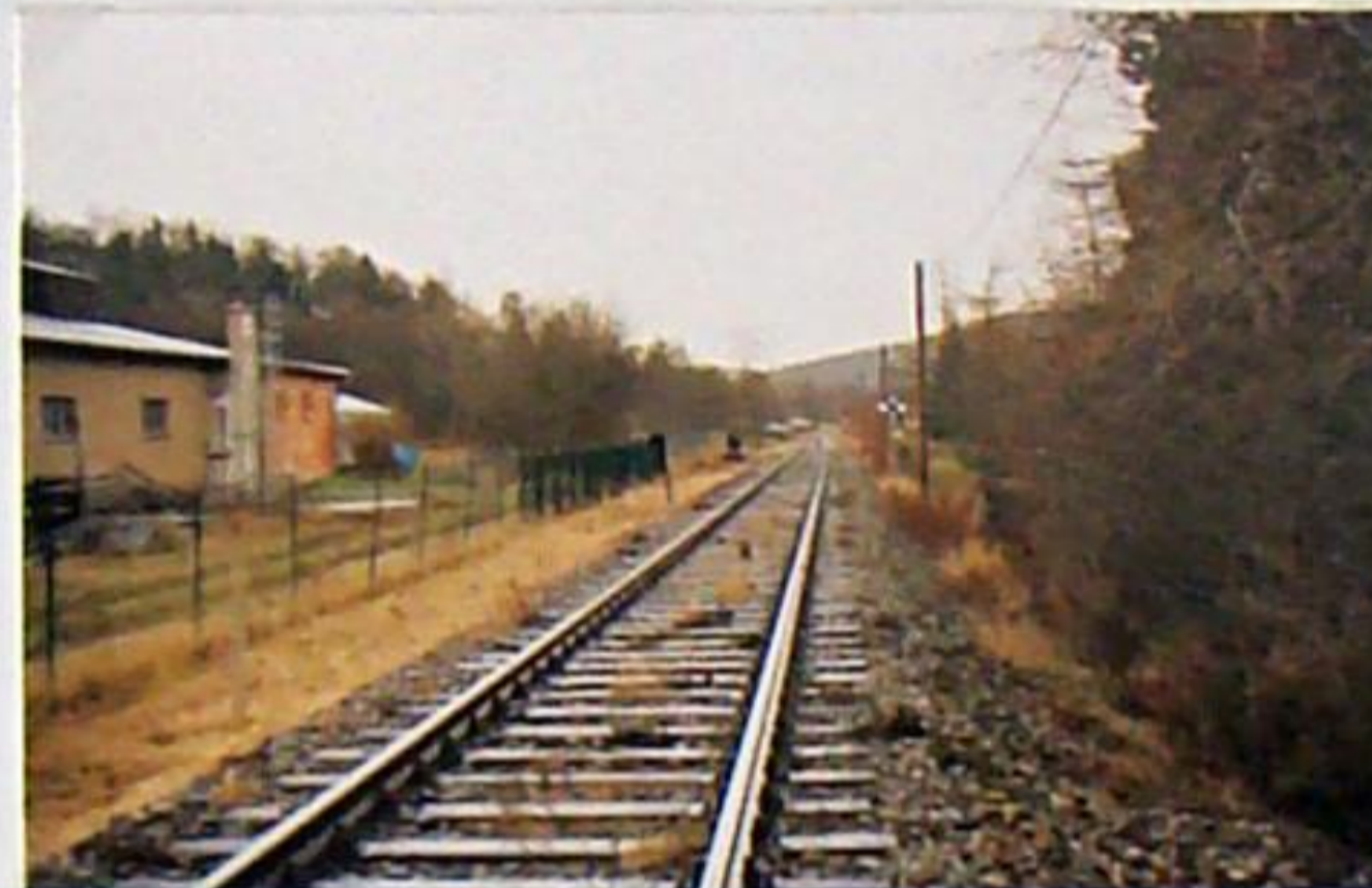
Nach 1965 entstand auf dem ehemaligen Kohleplatz die Baumschule. Die Kreuztafel zum Einfahrsignal B stand auf km 18,136.
