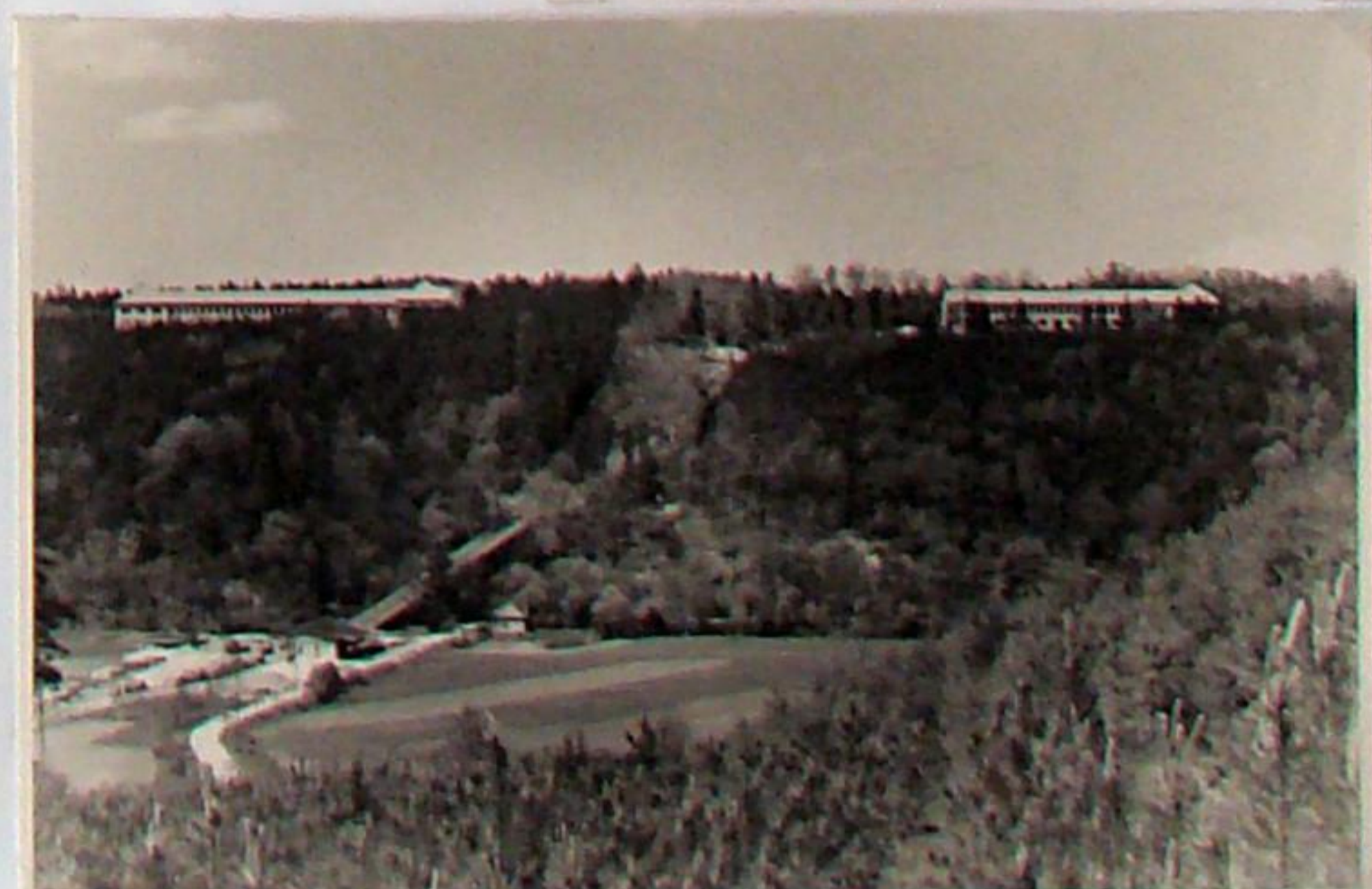
Der Neubau der Tbe-Heilstätte auf der Harth erforderte große Mengen an Baustoffen. Deshalb wurde 1951 neben der „Schwarzen Brücke“ über die Ilm, am heute zugewachsenen Weg zum Dreiteichsgrund, ein Materialbahnhof mit anschließender Standsseilbahn errichtet. Die Anschlussweiche lag im km 18,770 vor dem Anschluss Martinswerk. Das Gleis beschrieb einen Bogen von 90 Grad und teilte sich dann zweimal auf. Beide Güterbühnen fassten bis zu drei Kipploren die an den Lagerplätzen von Hand gefüllt, über Fluss und Straße, nach oben gezogen wurden. Rechts ist die Seilbahn von oben zu sehen. Zustand 1952
