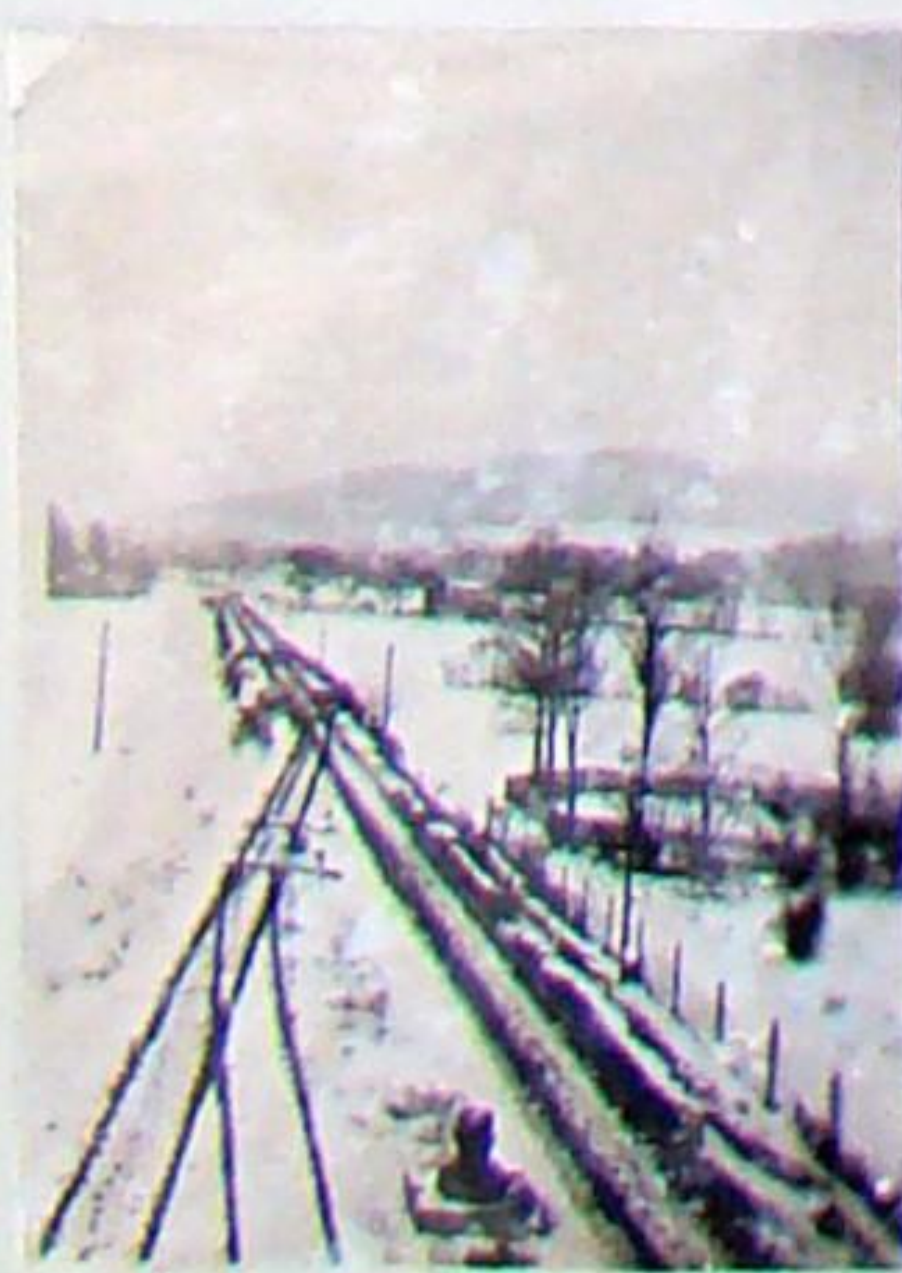
Blick vom Portalkran der Kohleentladung in Rtg. Sportplatz. In der Bildmitte die Anschlussweiche - folgend Gleissperre, Linksweiche und Elektroseilwinde neben dem Übergabegleis.
