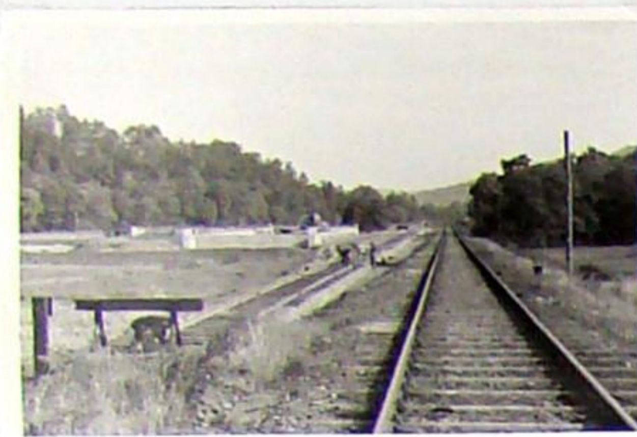
Die ab 1951 im Bau befindliche Tbe-Heilstätte auf der Harth benötigte für das Heizhaus eine zentrale Kohlezufuhr. So entstand bis 1956 am km 18,040, oberhalb der zweiten Flutbrücke, der Anschluss „Kohleentladung Tbe-Heim“.
