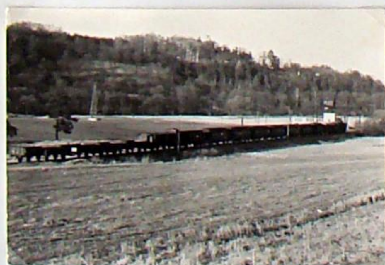
Im Winterhalbjahr 1963/64 stehen die Anlagen noch. Ein Doppel-Personenzug mit Güterwagen fährt nach Bad Berka → Die Blankenhainer Strecke ist noch in Betrieb.
