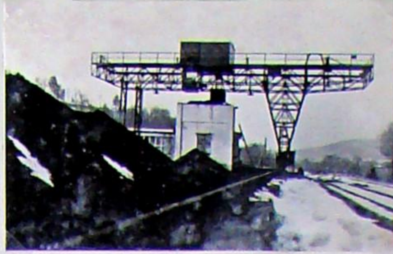
Links der Kohlebunker mit den Schienen für den Portalkran, mittig das Trichterhaus zum Füllen der Transportkübel und dahinter das Maschinenhaus. Rechts das Übergabe- und Entladegeleis.
