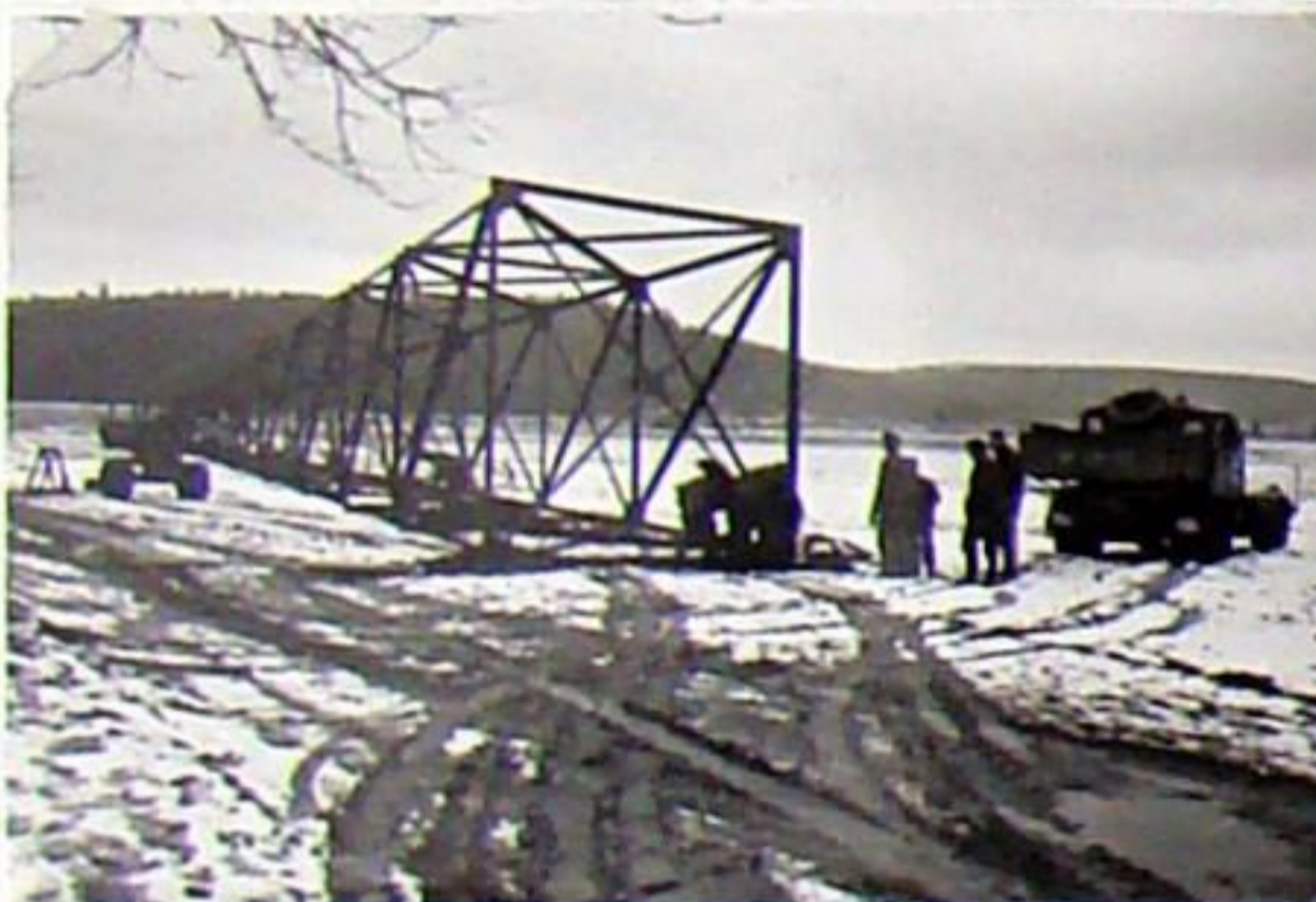
Für den Transport auf die Anhöhe wurde eine Drahtseilbahn gebaut. Hier wurde gerade einer der beiden Gittermasten angeliefert.
