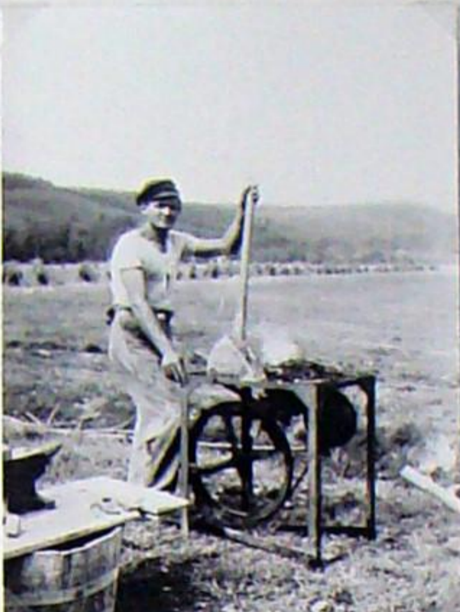
Der Schmied war ein wichtiger Helfer vor Ort. Er musste die abgenutzten Werkzeuge im Schmiedefeuer erwärmen und auf dem Amboss neu ausschmieden. Zur Feueranfachung diente das mit dem Fuß zu betätigende Gebläse.
