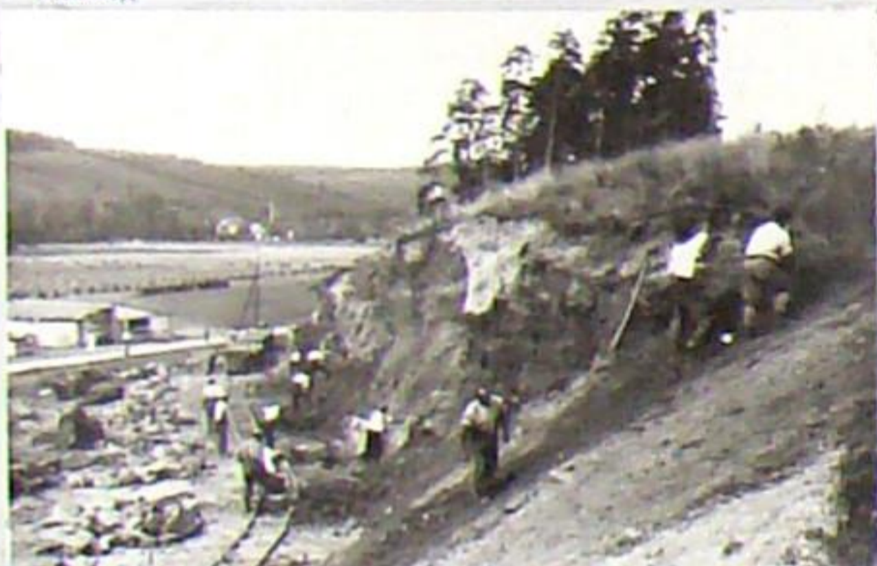
Hinter der „Martinswerkkurve“ begann man 1930 zur Gewinnung von Erdstoffen zur Dammschüttung, den Nordwesthang auf etwa 300 m Länge per Hand abzuschichten. Dabei wurden die großen Steine besonders gesammelt und die Baumwurzeln aussortiert. Im Hintergrund die Kipporen zur Dammschüttung, dahinter das Martinswerk.
