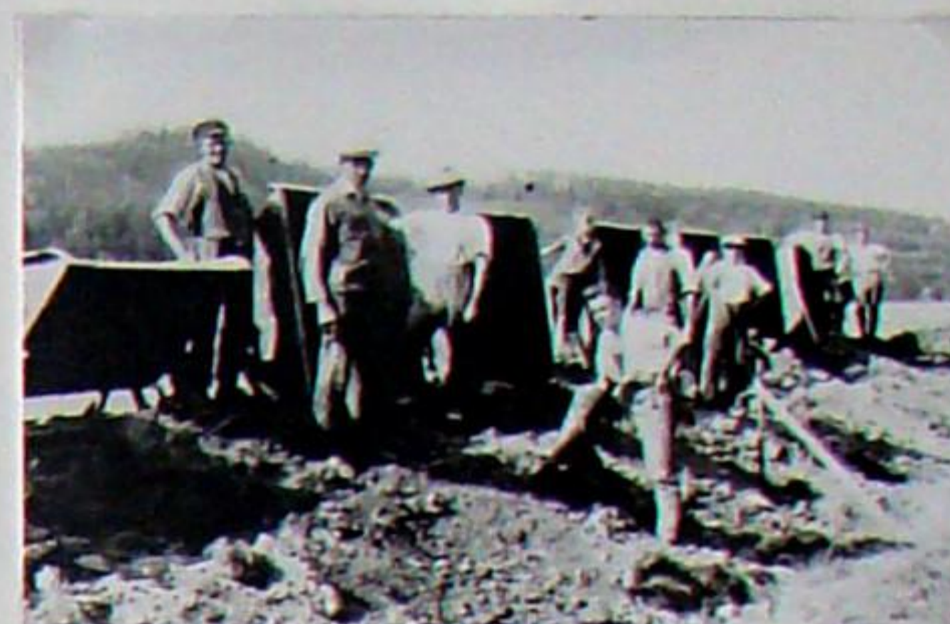
Die Schüttstelle ist erreicht! Die Erde muss nur noch an die richtigen Stellen verteilt werden.
