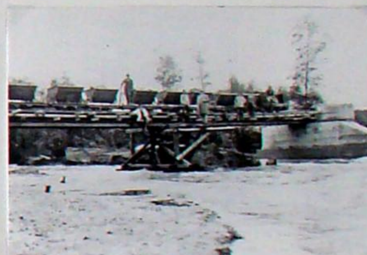
Auf den neuen Brückenfundamenten liegt ein Provisorium aus Stahlträgern, Holzern und Feldbahn-Gleisjochen um die beiderseitige Dammschüttung zu ermöglichen. Ansicht von der Tannrodaer Straße aus.
