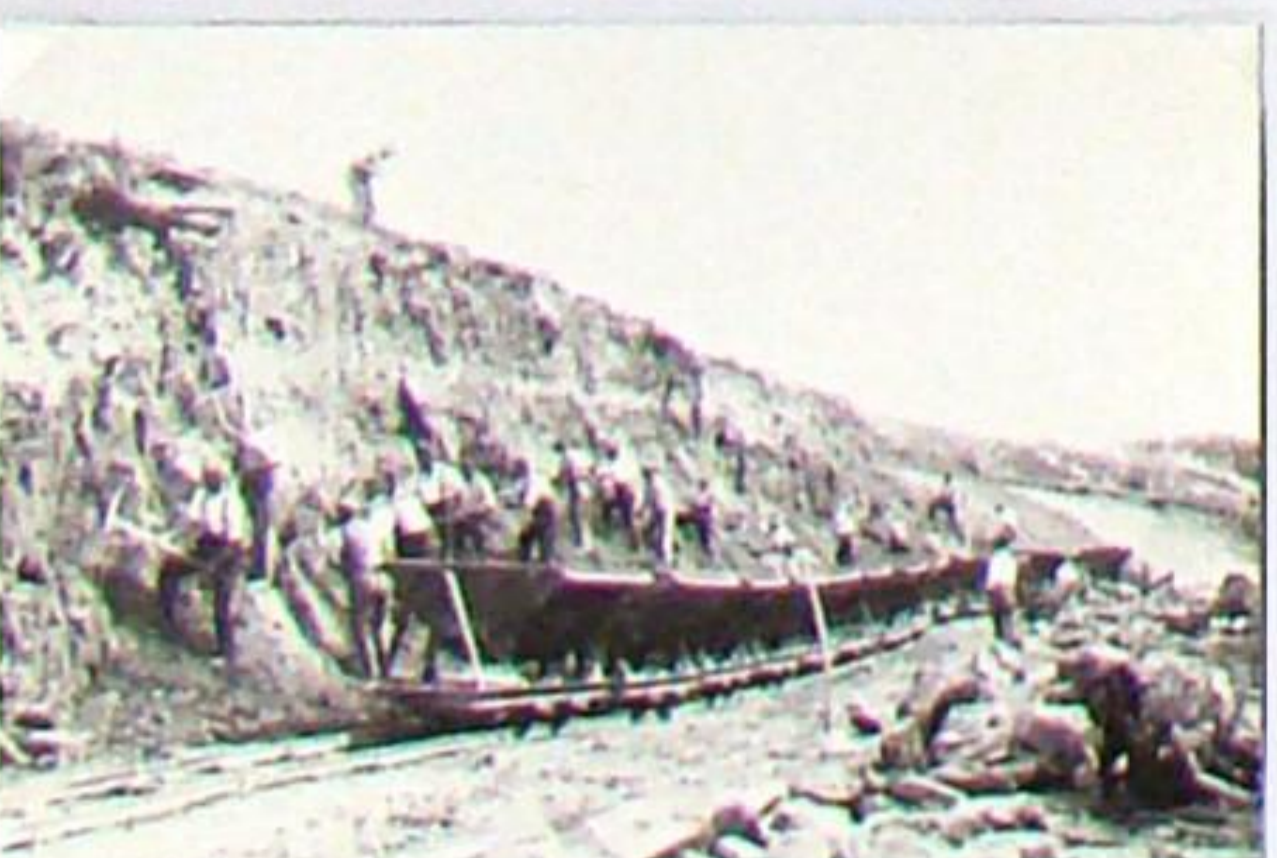
Die großen Steine sollten den neuen Damm im Untergrund stabilisieren.
