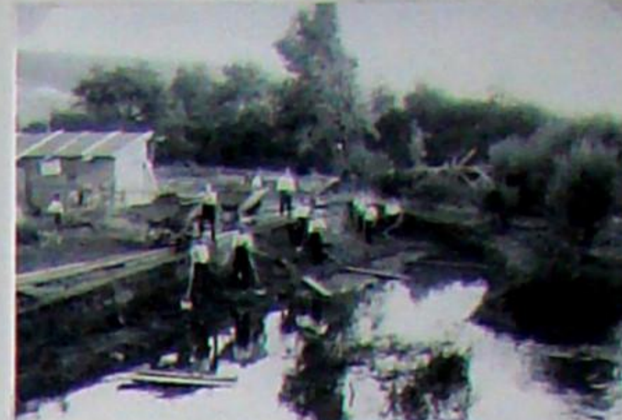
Die Arbeiter im Auftrag der „Generalbauleitung Hermann Schäfer, Hoch- und Tiefbau Weimar“ graben hier das neue Flussbett. Im Hintergrund wird gerade die neue Ilmbrücke „befahrbar“ gemacht.
