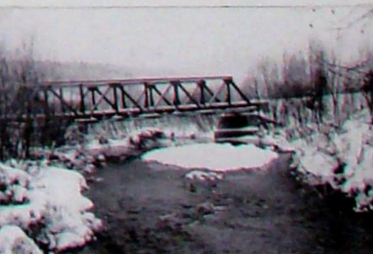
Die fertige Eisenbahnbrücke in km 26,65 bei München im Winter 1939.
