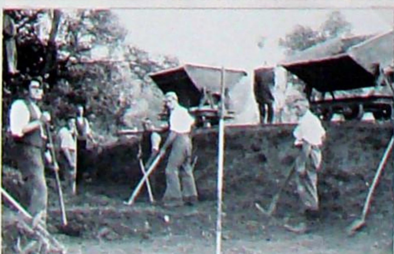
Für die Dammschüttung der neuen Eisenbahnstrecke wurden 1930 große Mengen Erdstoffe benötigt. Gleichzeitig erforderte die neue Ilmbrücke vor München eine Flussbettregulierung. Die Erde wurde damals aus dem Flussbett in Etagen in die Kipporen geschaufelt und diese dann zur Schüttung per Hand weiter geschoben.
