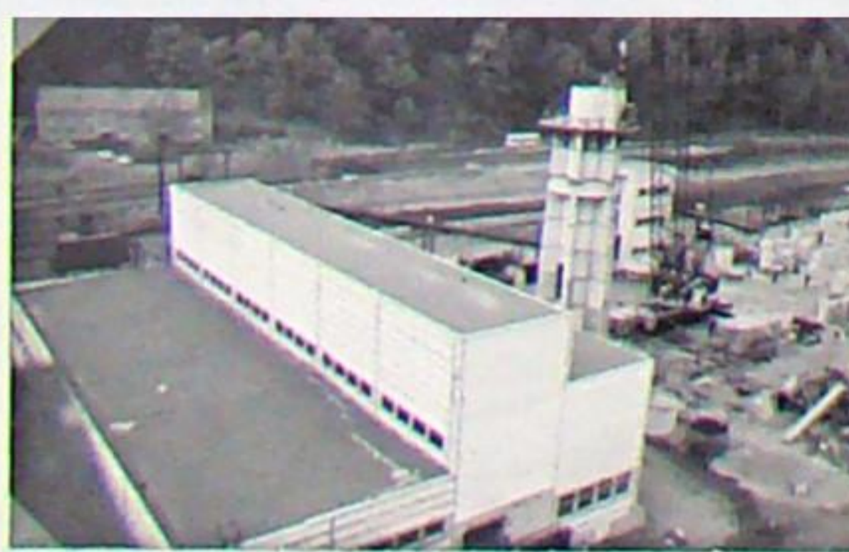
Bau des Kohleheizwerkes Tannroda 1983
