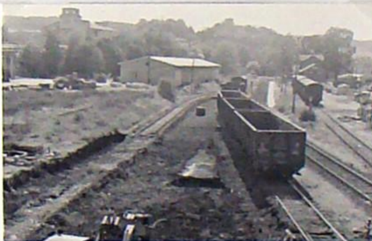
Bahnhof Tannroda - Blick zum Bahnhofsgebäude Herbst 1983
