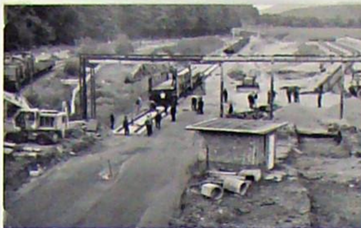
Tannroda August 1983: Bau des neuen Streckengleises zwischen km 21,2 bis zum Bahnhof. Links auf dem alten Streckengleis neben der Hauptstraße stehen 2 Dieselloks der Baureihe 106
