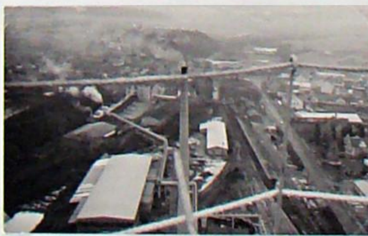
Blick vom Schornstein des Kohleheizwerkes Tannroda Richtung Papierfabrik Ende 1983
