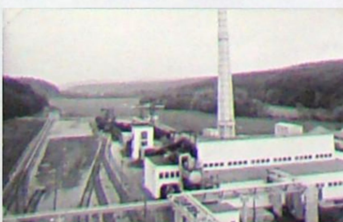
Der Kohlebunker des neuen Heizwerkes 1984
