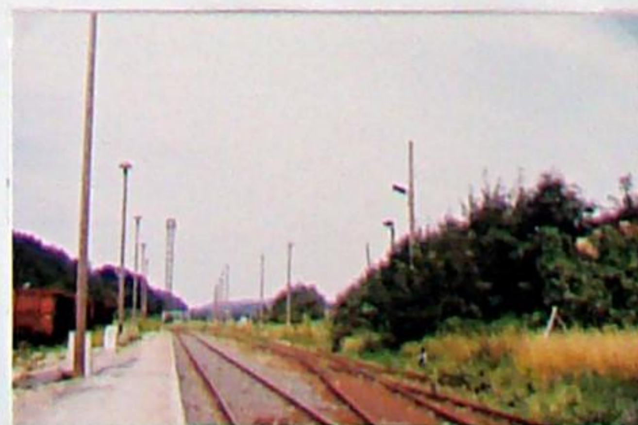
Bahnhof Tannroda am 23.7.1994. Haupt- und Ladegleis sind noch in Betrieb.
