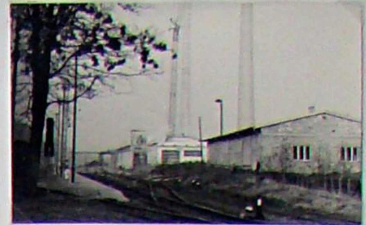
Kohleheizwerk Tannroda vom Güterschuppen aus gesehen im Frühjahr 1984
