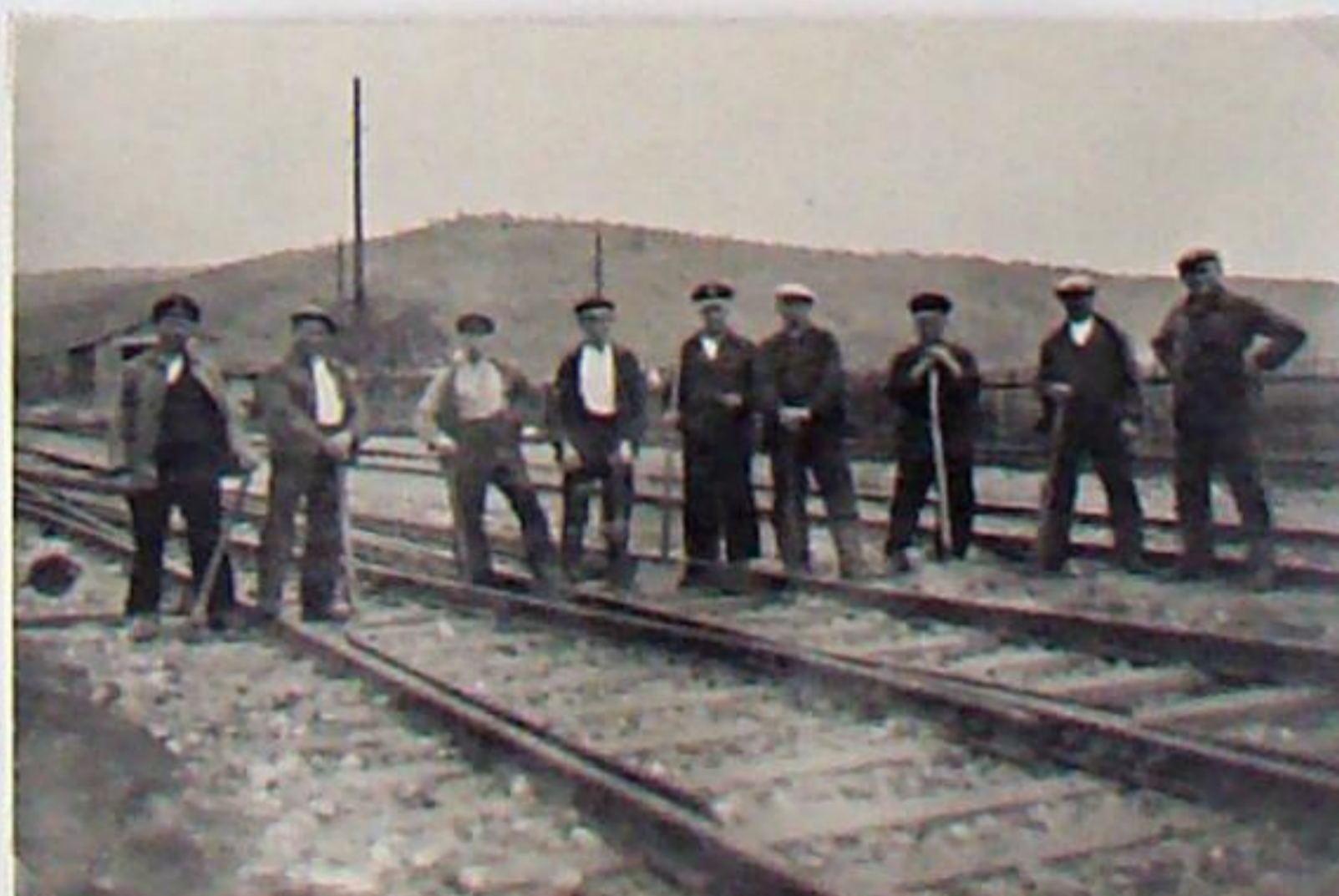
Nach geleisteter Arbeit stellt sich die Gleisbaurotte dem Fotografen – etwa 1939
