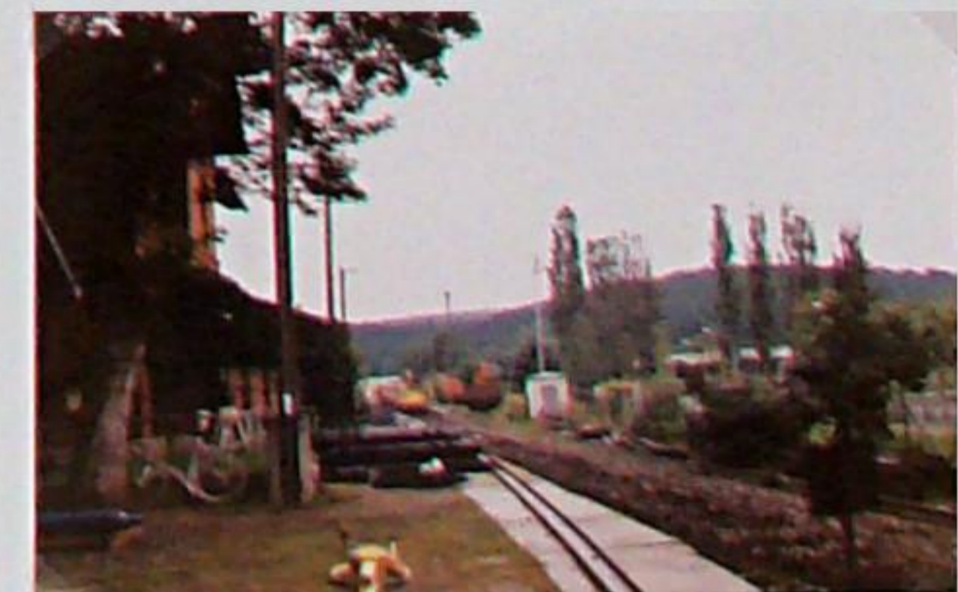
Kranichfeld am 24.8.1996: Bauarbeiten zum Neuaufbau von Gleis 1
