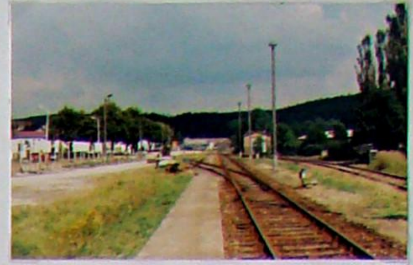
Ladestraße im Bahnhof Kranichfeld – der Rückbau hat noch nicht begonnen
