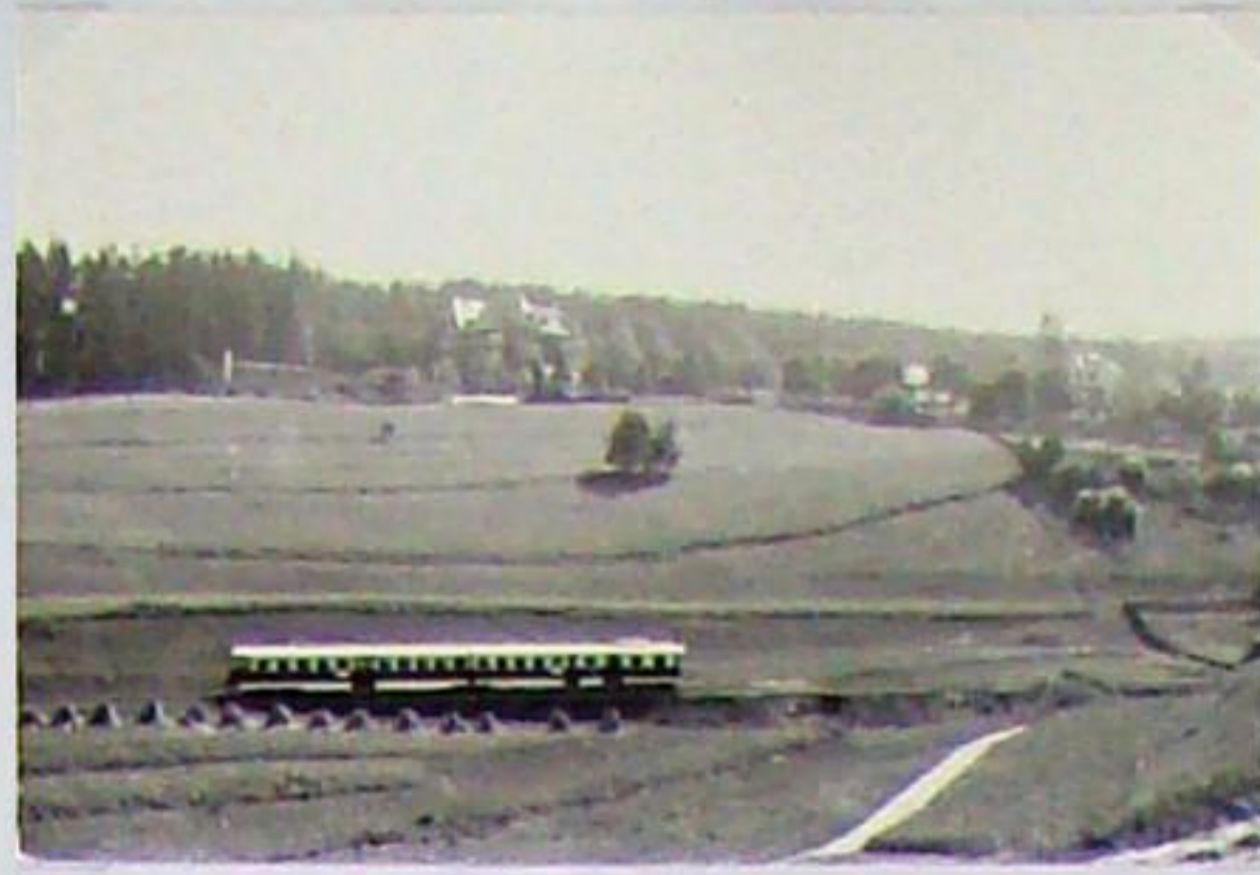
Triebwagen T 05 auf der Fahrt von Blankenhain nach Bad Berka unterhalb der Wilhelmsburg um 1938
