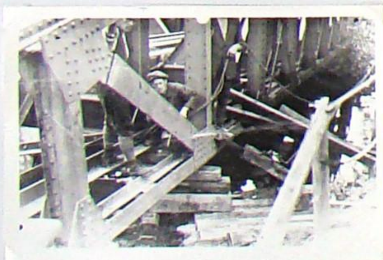
Zerschneiden der ausgebauten Schwedler-Brückenträger
