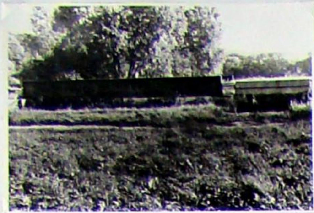
Die beiden Flutbrücken sind Ersatzbauten. Die kleinere am km 0,184 erhielt 1923 einen neuen Überbau aus 20 Schienen Profil 10 in Beton. Der Blechträger der Zweiten am km 0,194 stammt von der Fa. Klörne aus Dortmund aus dem Jahr 1926. - Hier am 08.07.1982.
