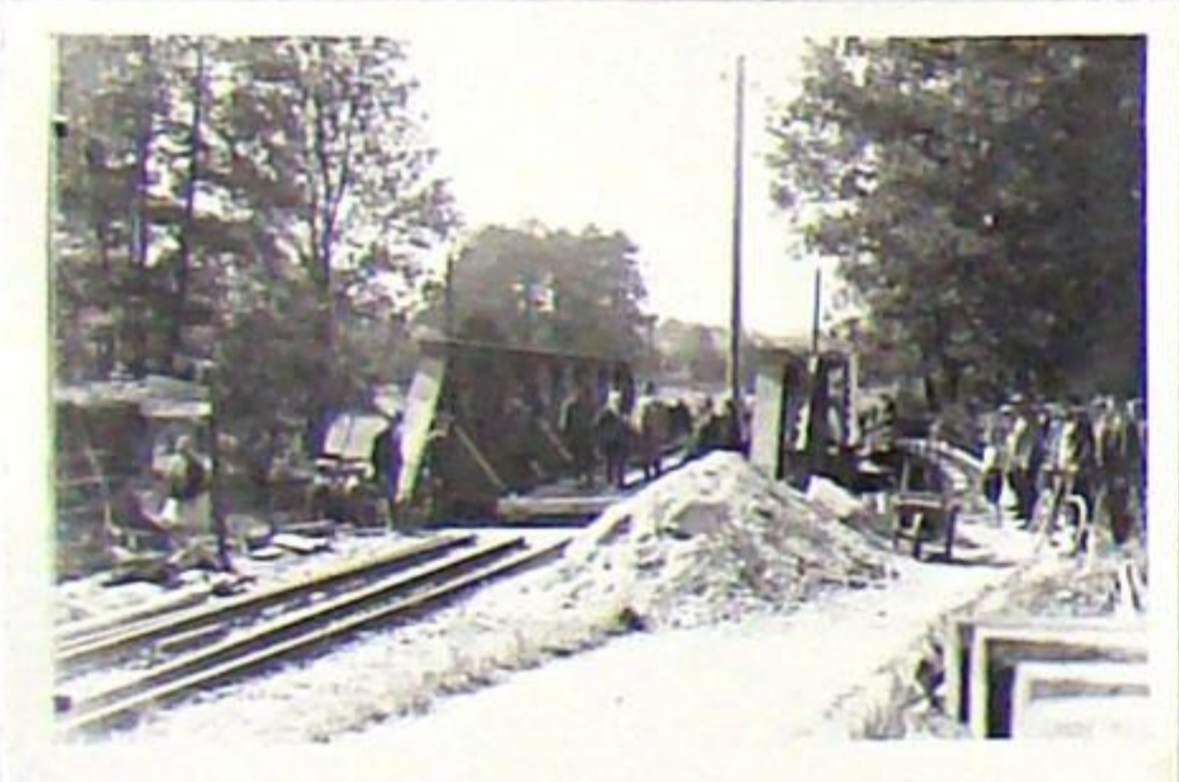
Blick von der Trebestraße auf die neu eingeschobene Ilmbrücke
