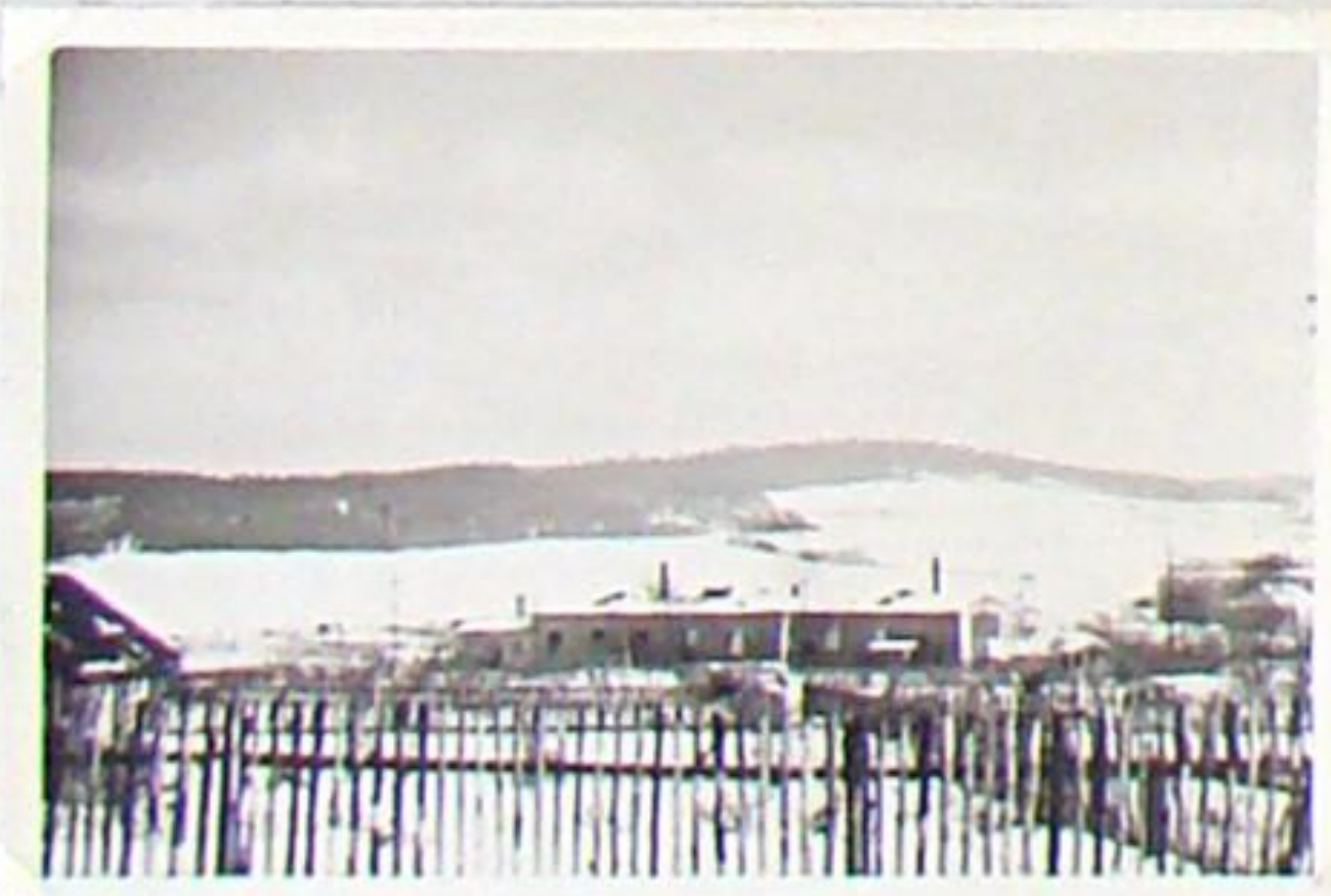
Blick von der ehem. F 85 auf den Lokschuppen in Blankenhain
