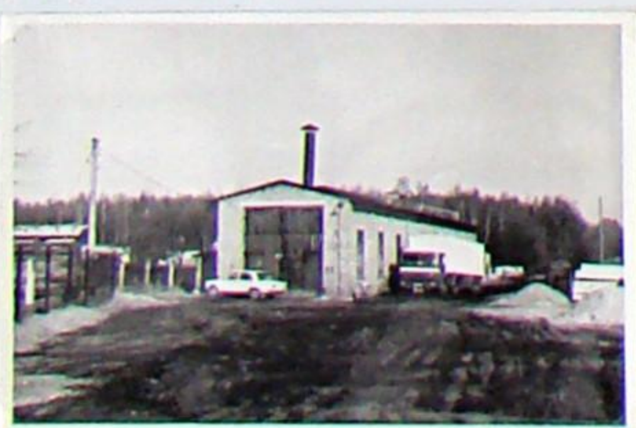
der 1927 gebaute und 1933 verlängerte Lokschuppen 1984 als Busgarage
