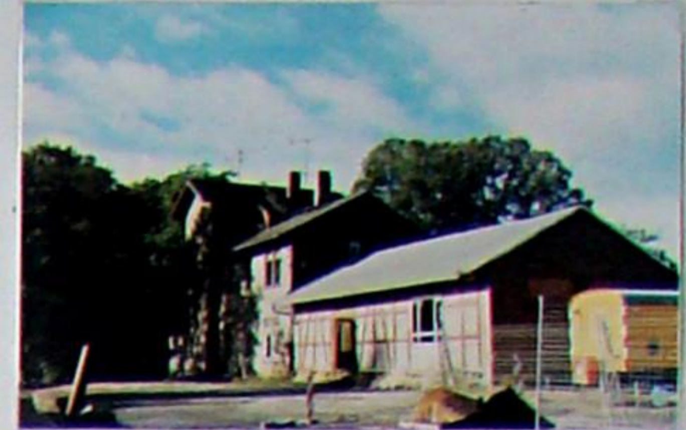
Die Straßenseite des ehemaligen Bahnhofgebüdes wenige Tage vor dem Abriss am 11.9.1994.
