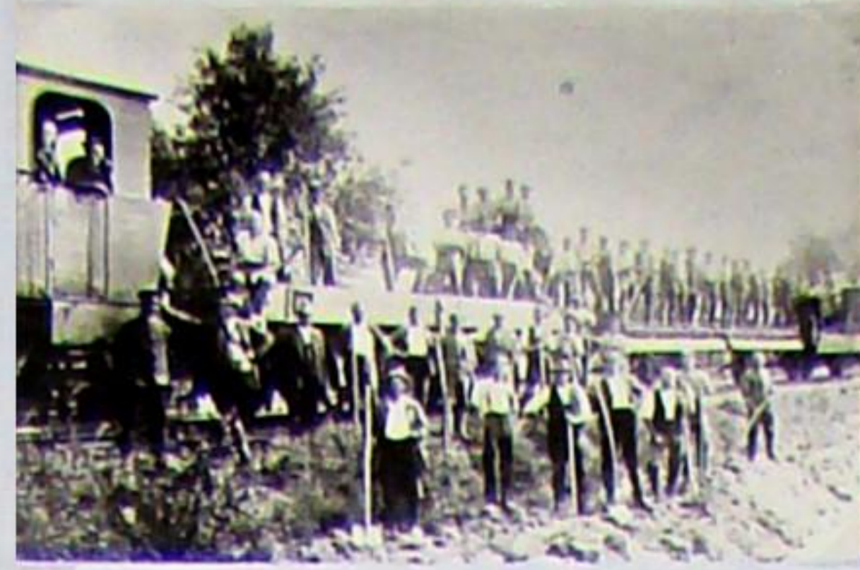
Streckenverlegung zwischen Tannroda und Kranichfeld 1927
