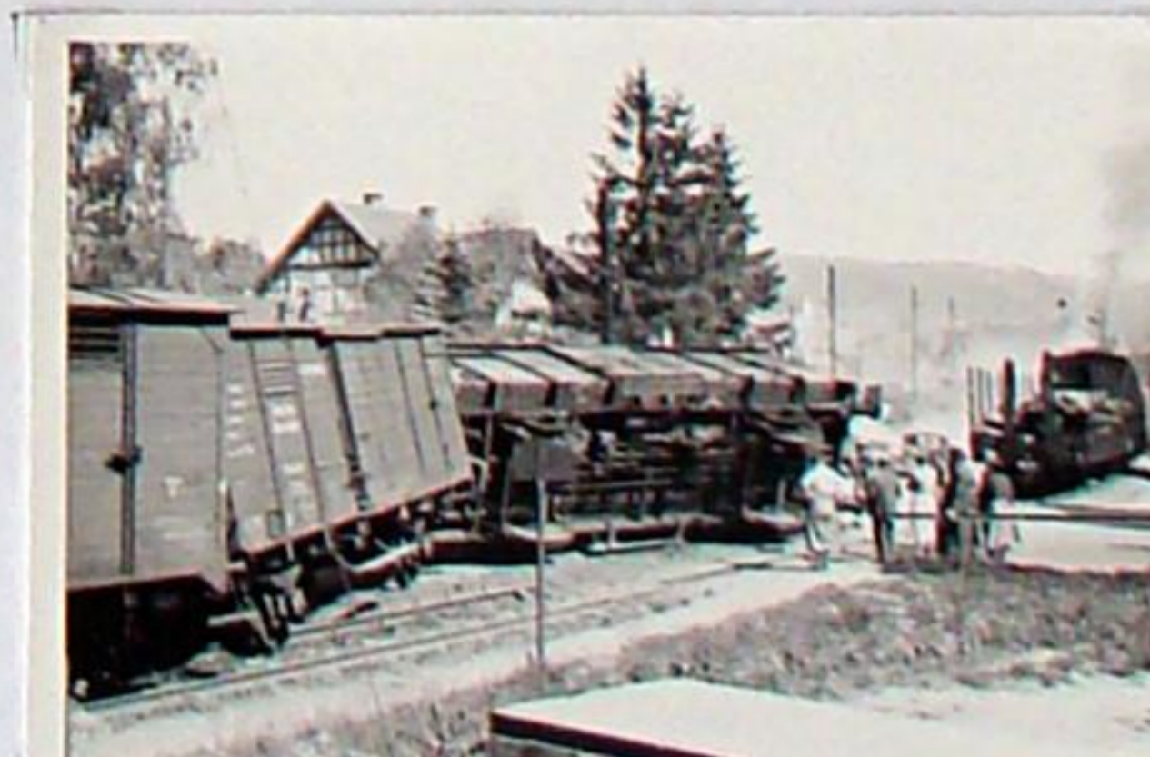
1939 entgleisten am Bahnübergang Tannrodaer Straße in Bad Berka mehrere Güterwagen. Für Eisenbahner, Bahnräte, Polizist und Reisende bedeutete das viel Ärger und Aufregung, für die Schaulustigen ein interessantes Spektakel.
