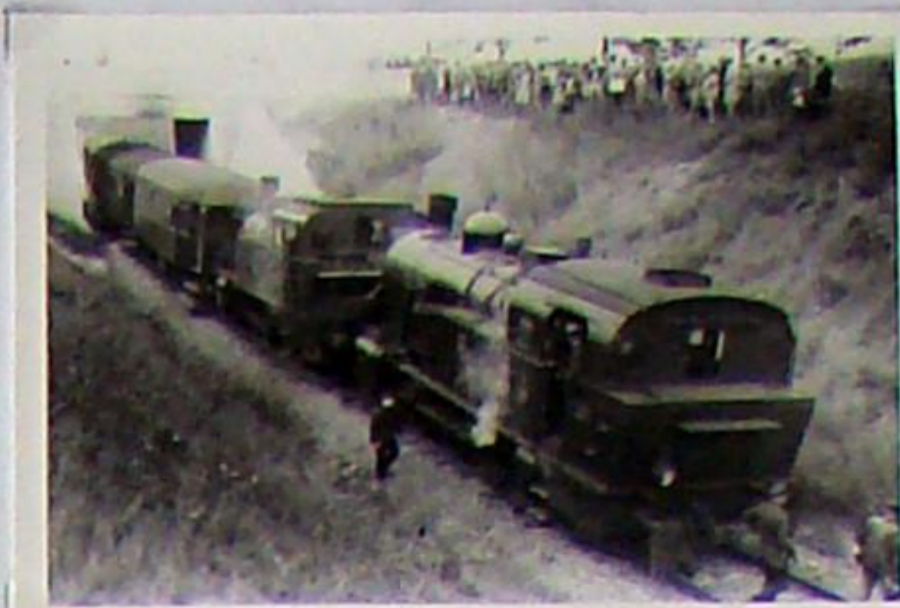
Am 10. Juli 1928 stießen Lok 93 und ein Personenzug von Weimar mit Lok 95 zusammen und wurden erheblich beschädigt (siehe dazu auch Informationstafel „Unfälle“)
