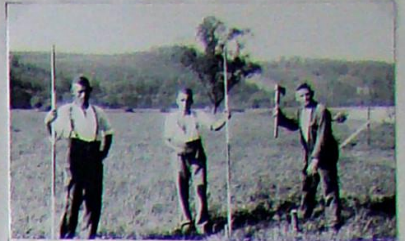
Die Helfer des „Geometer“ bringen die Messstangen nach Aufforderung in die richtige Position, damit die Vermessungspfähle und Grenzpfosten den späteren Streckenverlauf ordentlich markieren.
