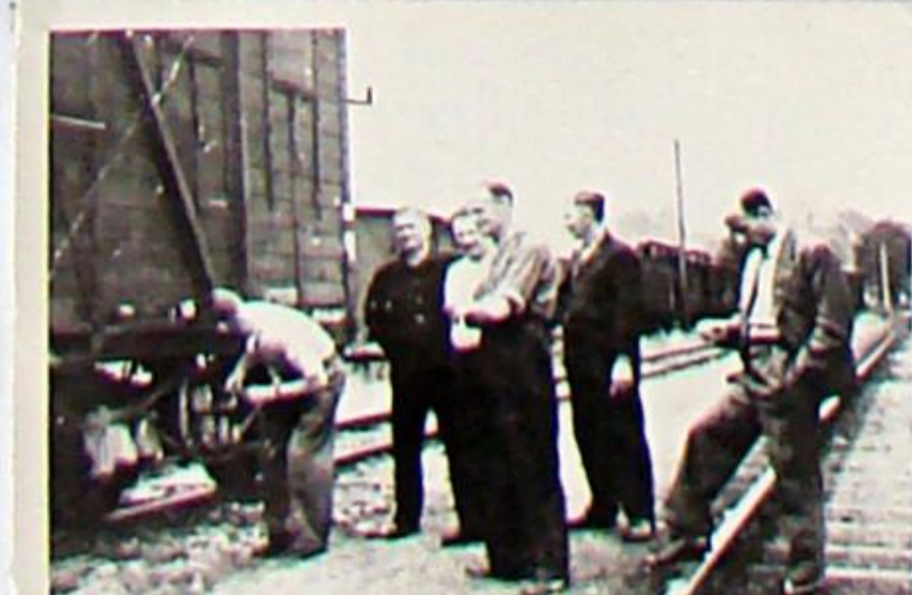
Einstellarbeiten an der Bremse eines Drehgestell-Güterwagens zur Probe-Belastungsfahrt für den neuen Triebwagen T 10, Tannroda 1941 (2.v.l.: Lokführer Arthur Hebestreit 2Monteur, 4.v.l.: LF Paul Hergt 1 Ingenieur, 5.v.l.: LF Otto Ludwig)
