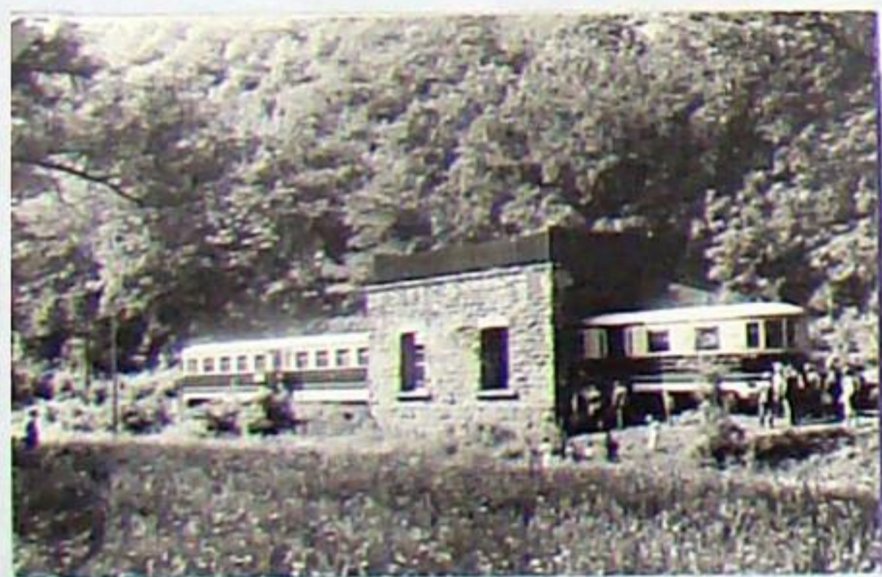
Am Pfingstsonntag, 16. Juni 1935 entgleiste der T 05 unter dem Schutzhaus der Drahtseilbahn am Zementwerk in Bad Berka wegen Radscheibenbruch an der zweiten Achse des Maschinen-drehgestells.
