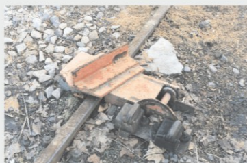
Gleissperre im Bf. Tannroda 1996 Foto: Matthias Geist
