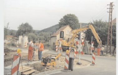
Bau der Halbschrankenanlage am Bad Berkaer Zeughausplatz 1993 Foto: Stadtarchiv Bad Berka
