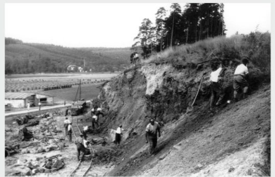
Dammschüttungen zum Gleisbau Nähe Marfinswerk um 1927
