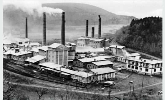
Zementwerk mit Eisenbahn um 1925
