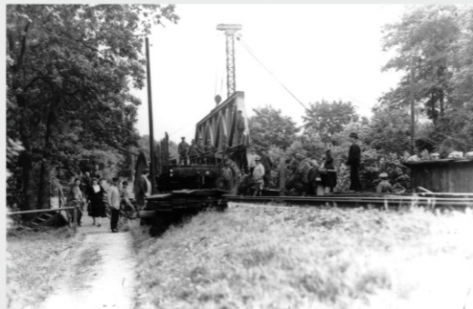
Bau Eisenbahnbrücke nach Blankenhain um 1928
