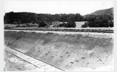
Gleisbau Nähe Schmalzgrube Bad Berka 1926 (Tieferlegung der Strecke zur Unterführung der heutigen B85) Foto: Haase
