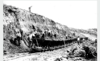
Gleisbau um 1928 Foto: Haase
