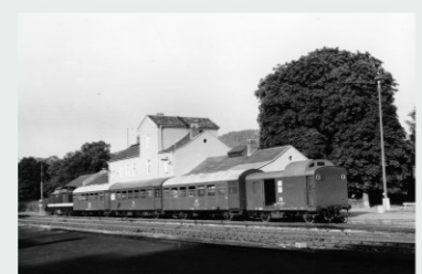
Diesellok 112 374 mit 3 Reko- und einem Gepäckwagen 1984 in Bad Berka Foto: Andreas Schaldach
