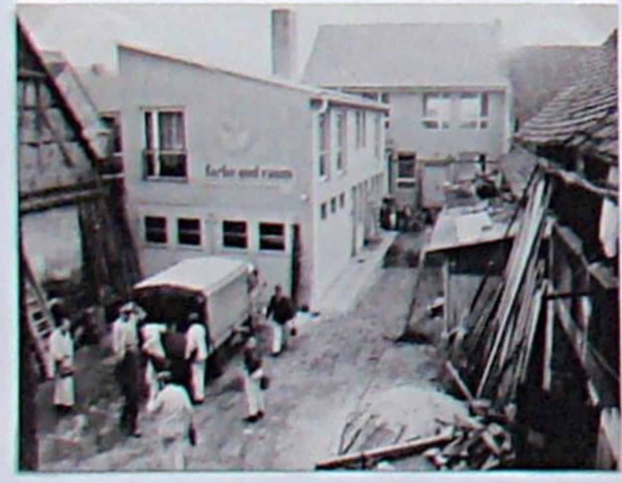
Errichtung der neuen Werkstatt 1967 - 1968
