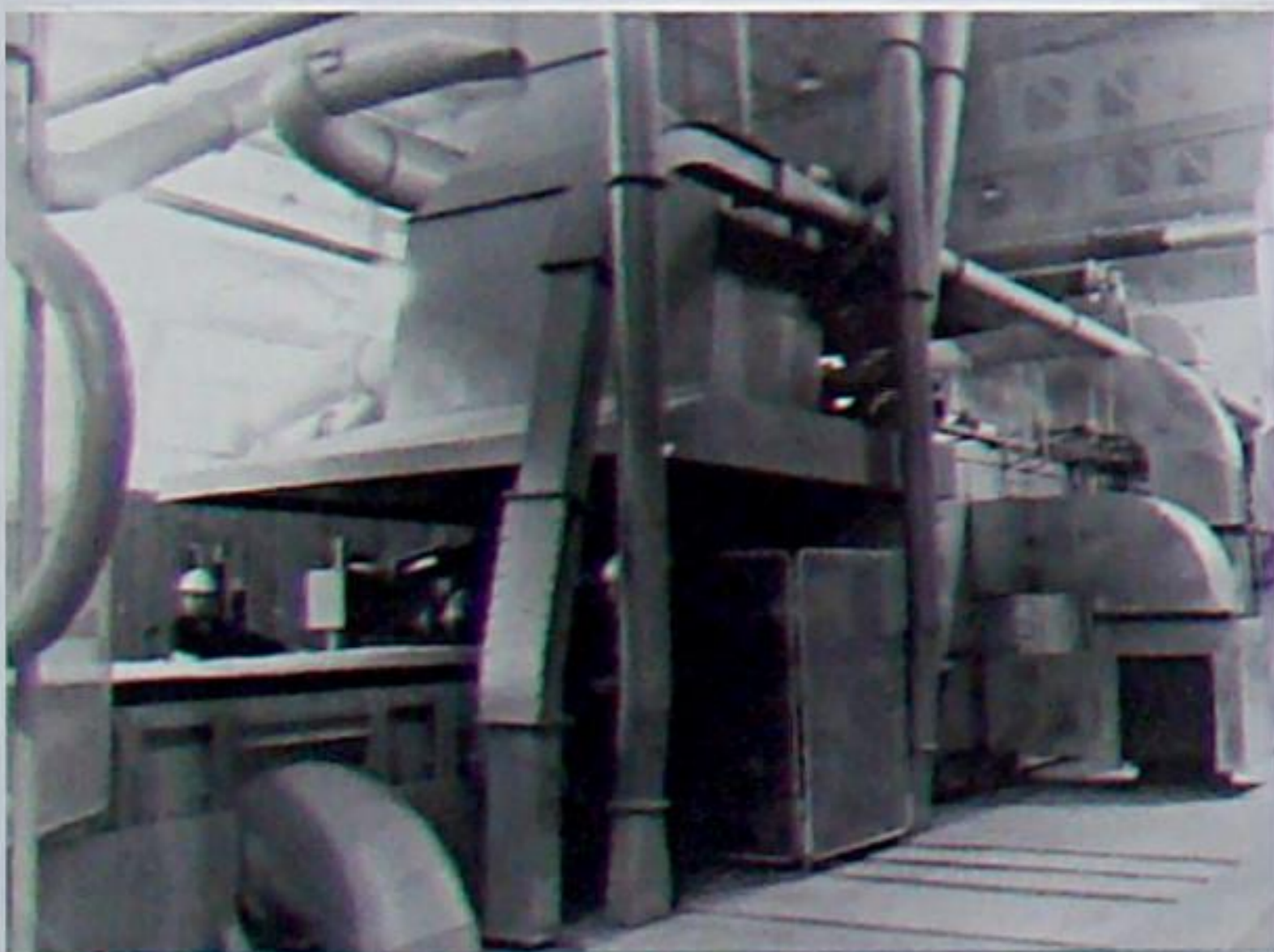
Montage der Schrägaufzüge zur Beschickung der Kupolöfen.
