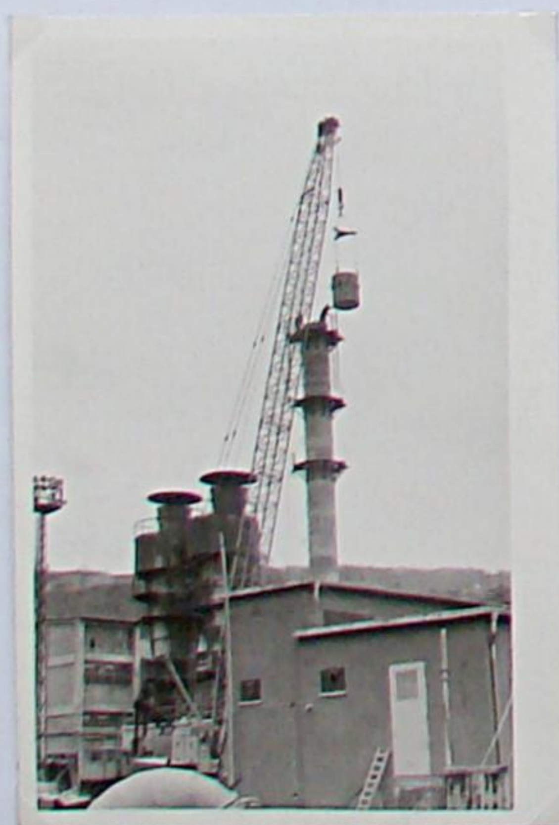
Abgasschornstein - Bau 1971
