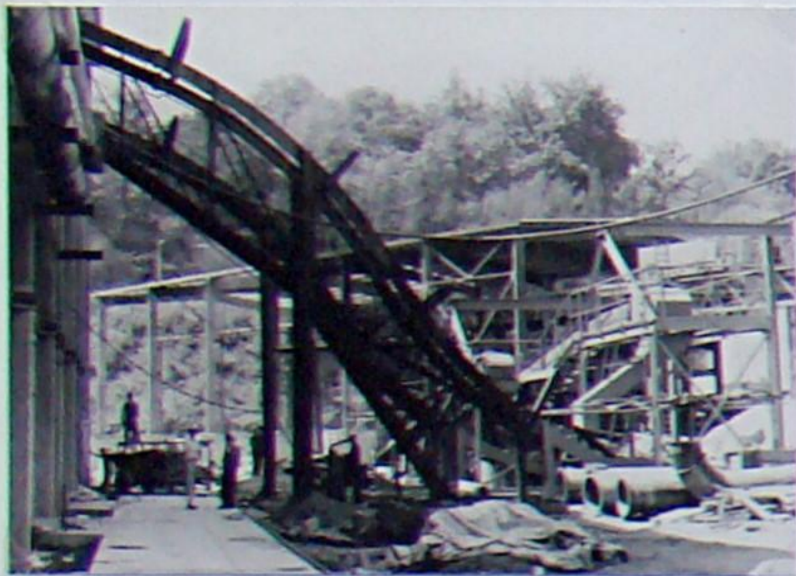
Montage der Schrägaufzüge zur Beschickung der Kupolöfen.
