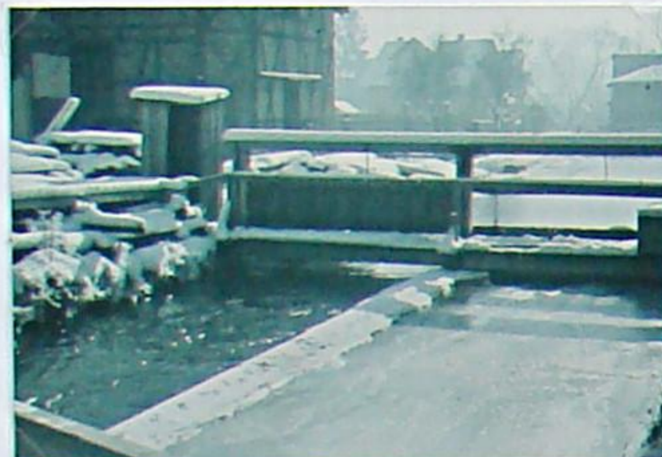
Das doppelläufige Gerinne beim Mühlgraben um 1950. rechts: für das Sägewerk; links: für die Untermühle
