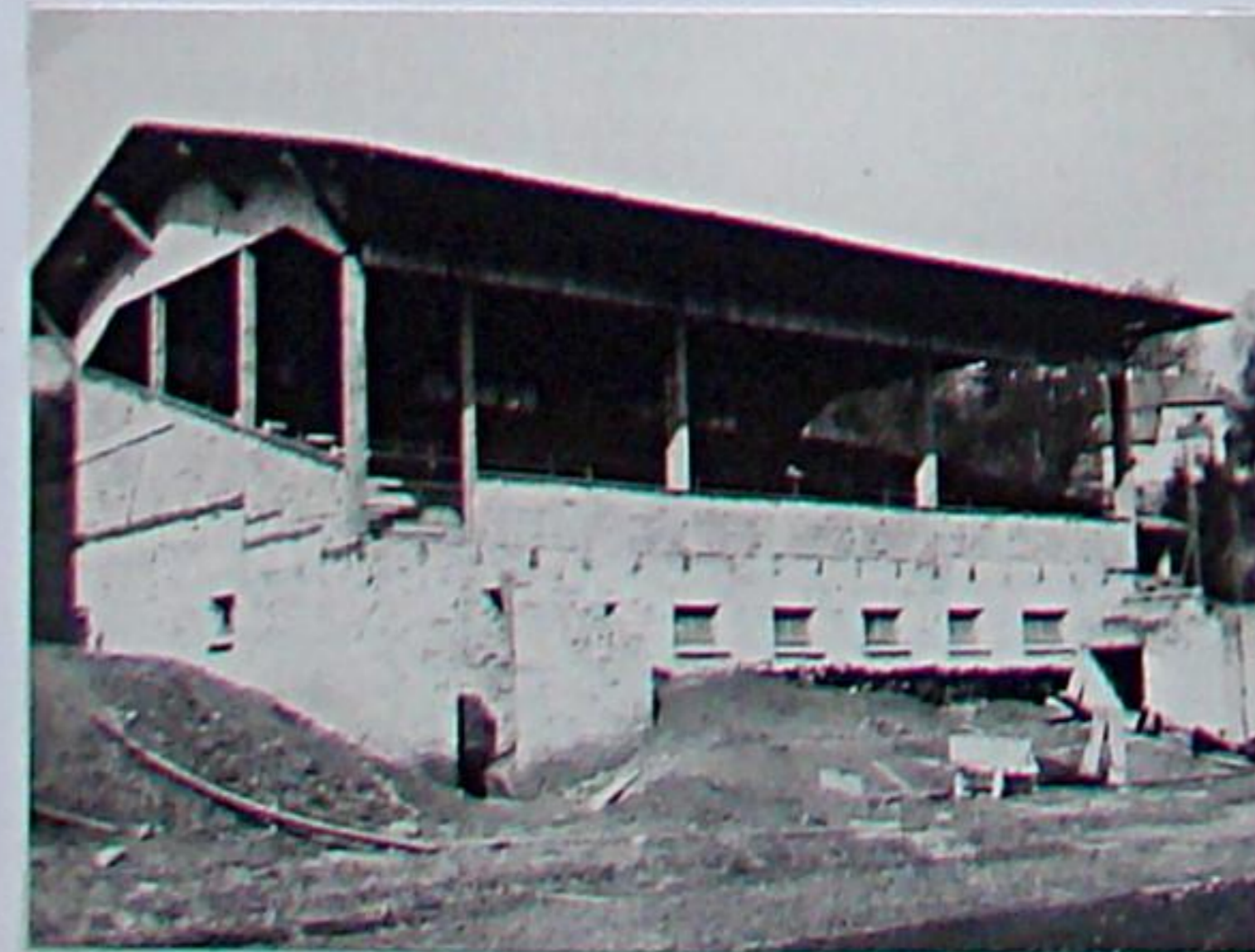
Errichtung der Zuschauertribüne am Sportplatz durch die Firma Geßner Mitte der 50er Jahre. Ein Teil der Arbeiten wurde im Nationalen Aufbauwerk geleistet.
