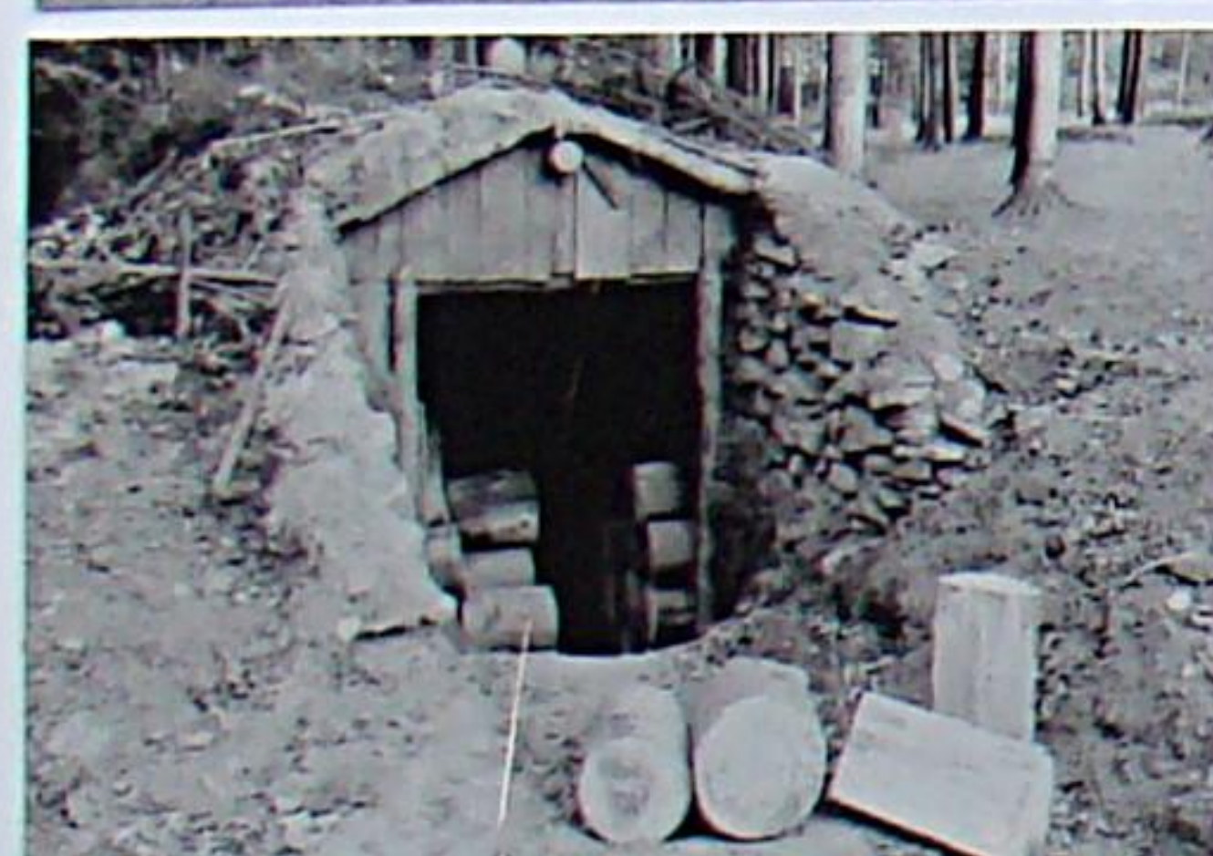
Um Devisen zu sparen, wurden Versuche unternommen, Bleistiftholz herzustellen. In einer Erdhütte wurde Buchenholz zum Verstocken gebracht. um 1960
