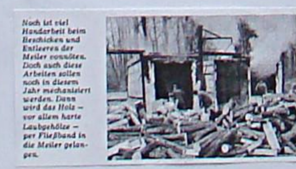
Noch ist viel Handarbeit beim Beschicken und Entleeren der Meiler notwendig. Doch auch diese Arbeiten sollen nach in diesem Jahr mechanisiert werden. Dann wird das Holz – vor allem harte Laubhölzer – per Fließband in die Meiler gelangen.
