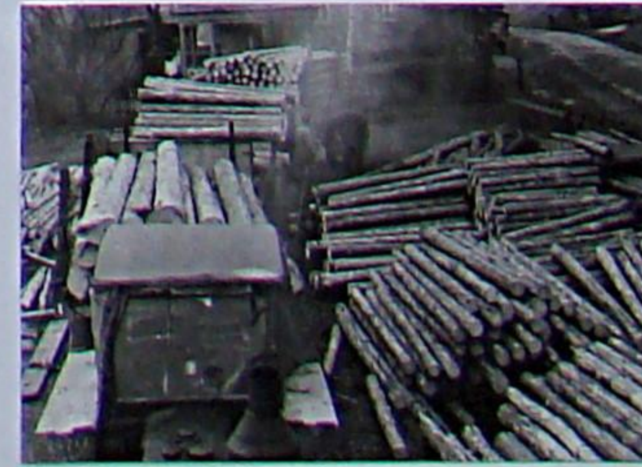
Holzumschlag am Bahnhof Bad Berka 1953
