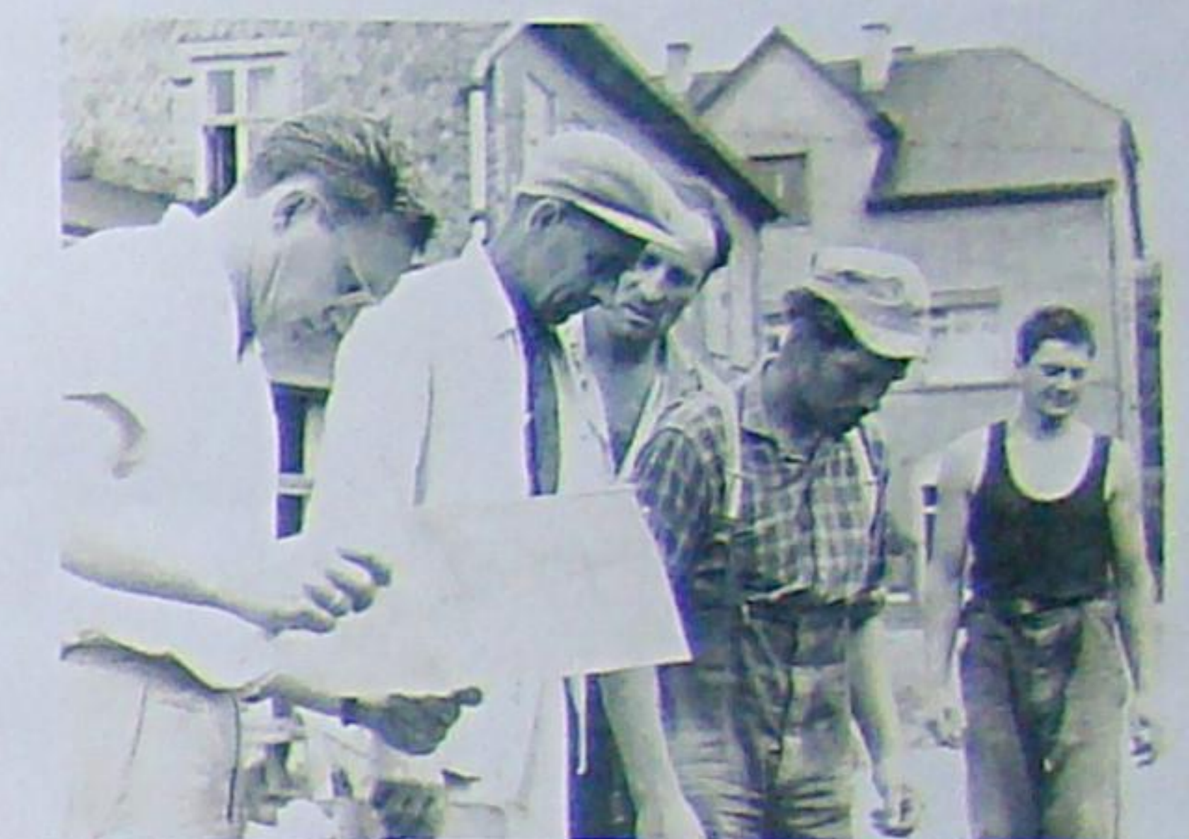
Brückenbau am Mühlgraben 1965 v.l.: H. Rötzer, A. Träner, H. Stadelmann, E. Plociczka, ?
