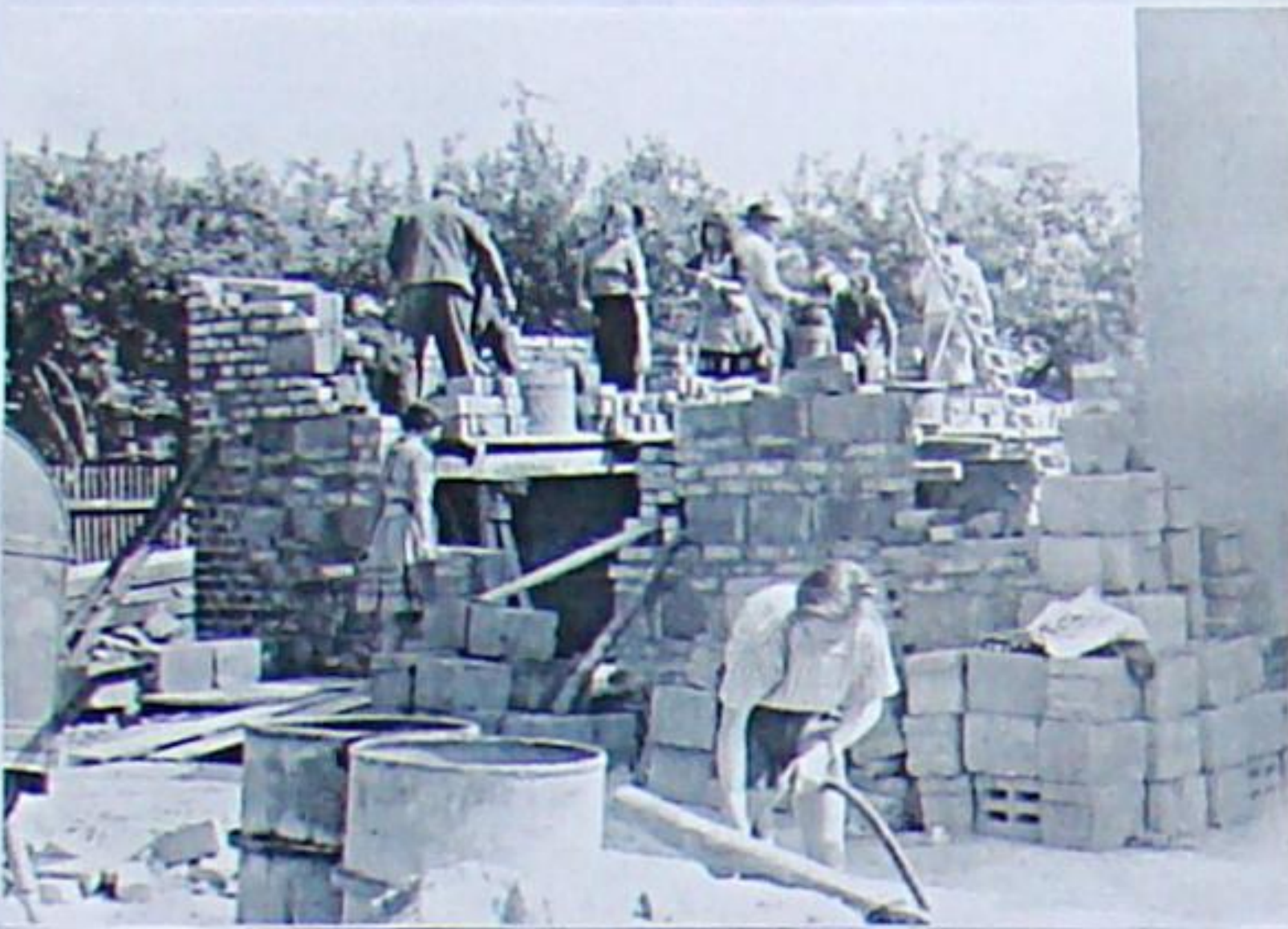
Welch ein Gewimmell – Baustelle: Kuhstallanbau für die LPG Bad Berka in der Weimarischen Straße.
