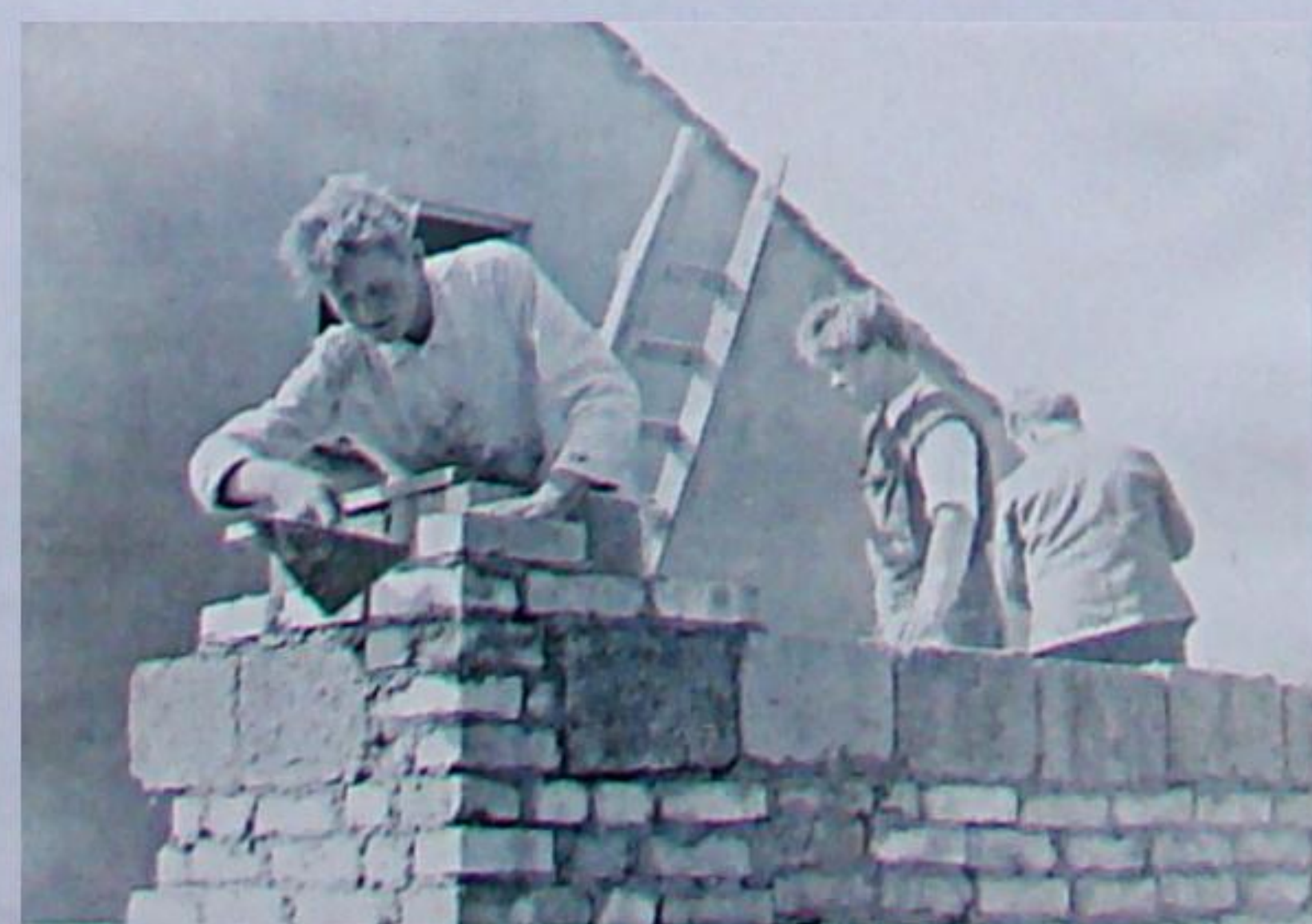
Die Ecke mauert Franz Reif selbst!
