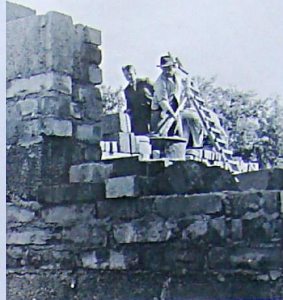
Kurt Pfothner zeigt das Mischen des Mörtels.
