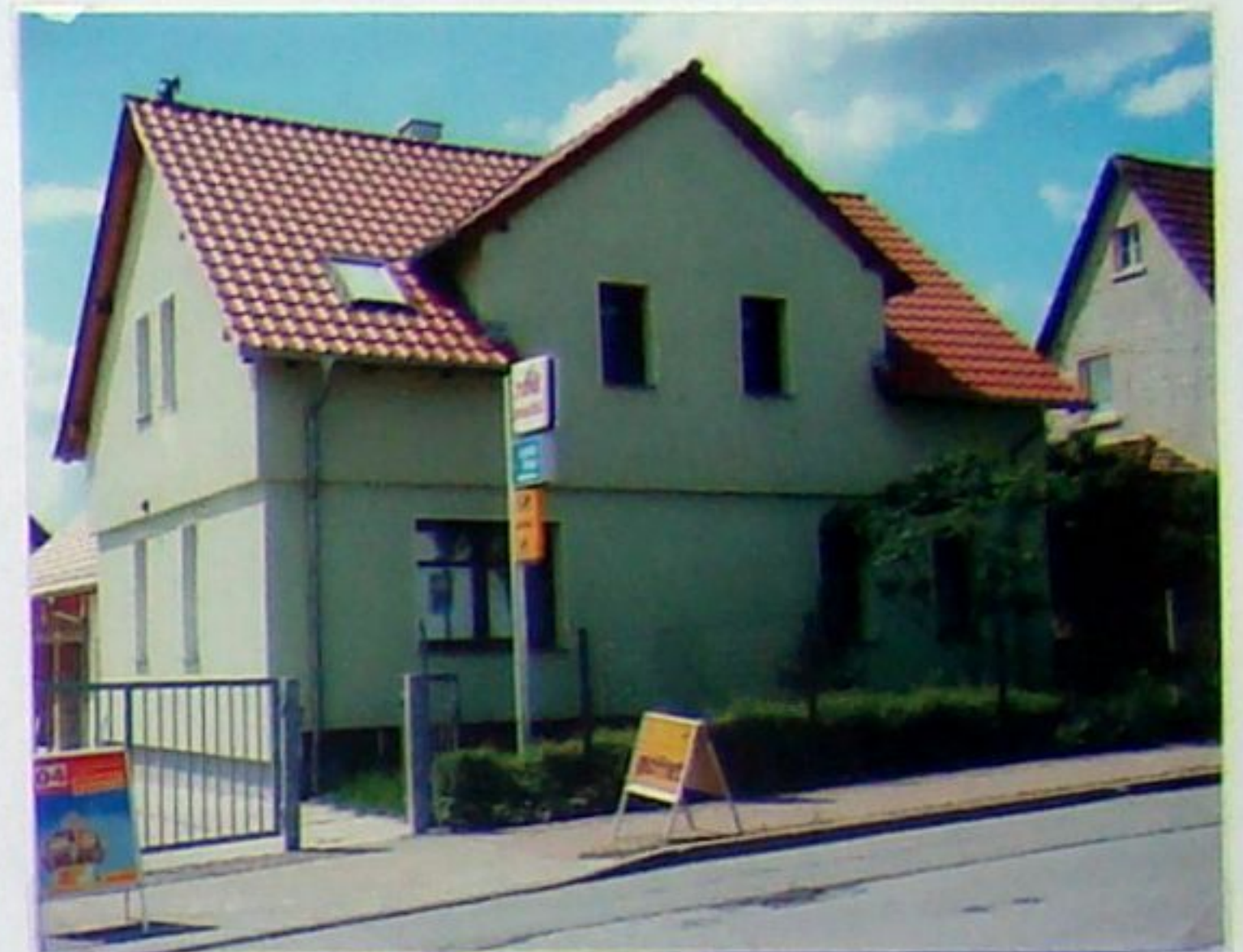
einst Gasthaus, heute Wohnhaus mit anschließendem Radmarkt und Poststelle – Mai 2009
