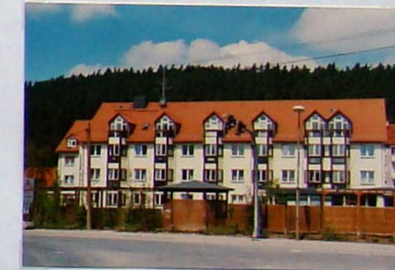
An Stelle der „ersten“ Henne entstand - etwas zurückgesetzt - ein Seniorenwohnheim
